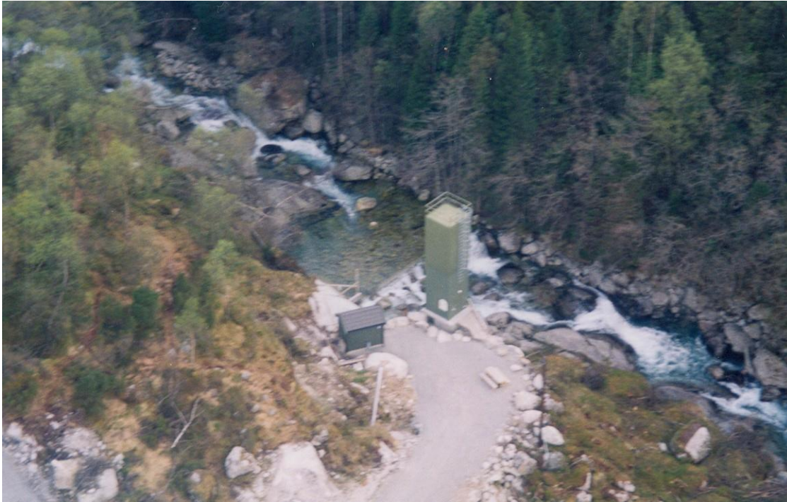
Figur 4: Kalkingsanlegget i Børsdalen
