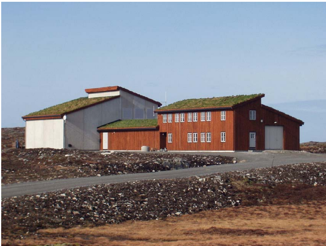
Figur 6.5 Eksempel på transformatorstasjon og servicebygg. Bildet er hentet fra transformatorstasjonen/servicebygget i Smøla vindpark. Transformator og øvrig tekniske installasjoner ligger i den venstre delen av bygget.
