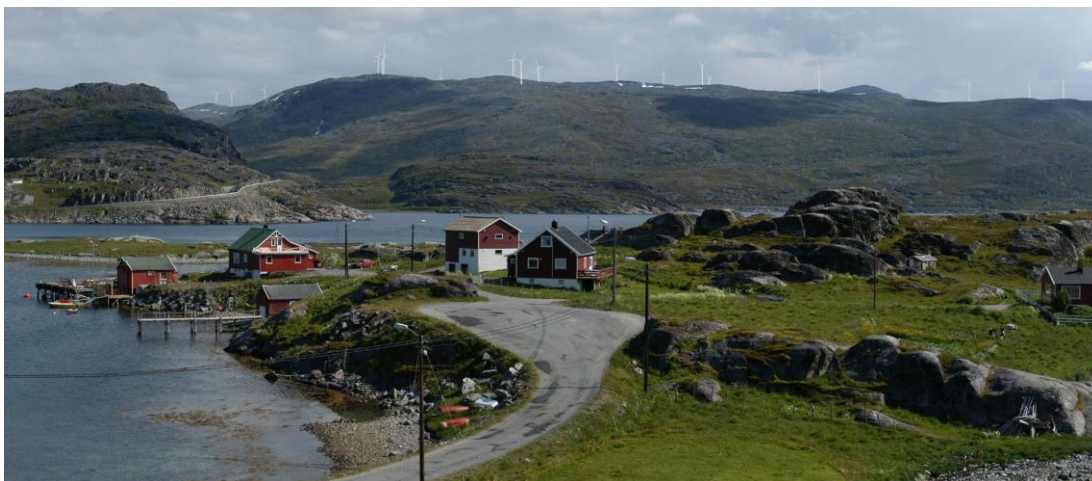
Figur 2.9 Deler av Hammerfest 2 MW vindpark sett fra Klokkerøya.
