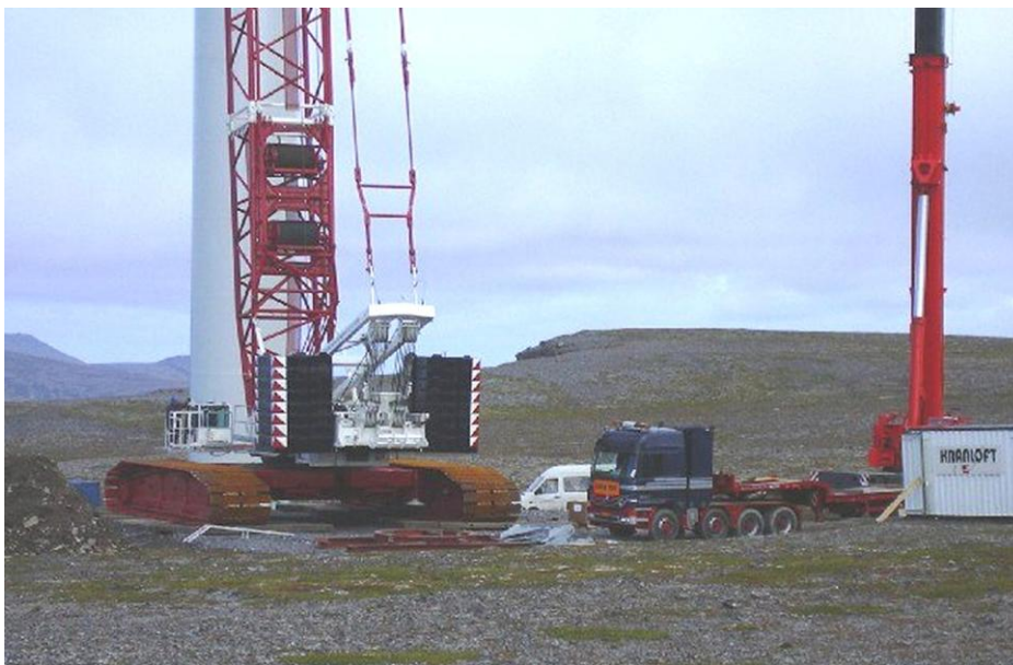
Figur 13.5 Riggområde ved oppsetting av møller på Gavlen, Havøysund.
