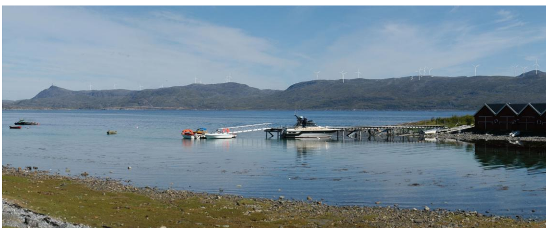
Figur 2.13 Deler av Hammerfest 5 MW vindpark sett fra Kvistnes på Seiland.
