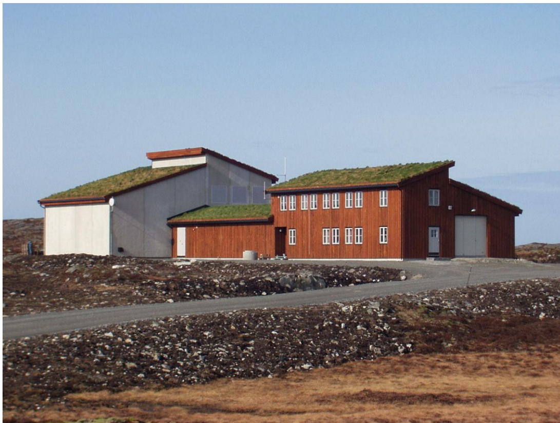
Figur 13.6 Eksempel på trafo- og servicestasjon (Smøla).
