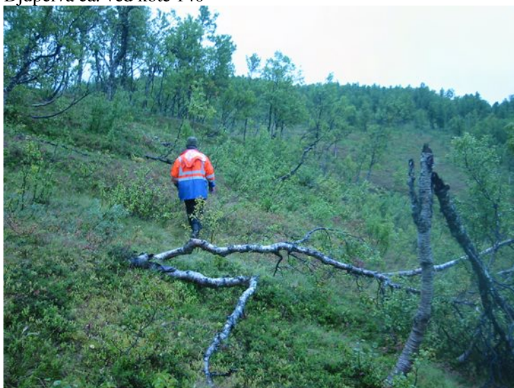
Rørgatetrase ca. 200 m nedenfor inntak
