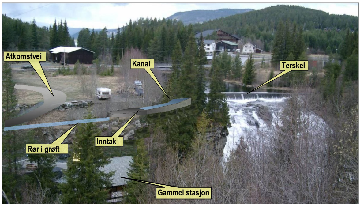
Figur 12 Eksisterende overløpsterskel og forenklet illustrasjon av inntak og første del av vannvei.
