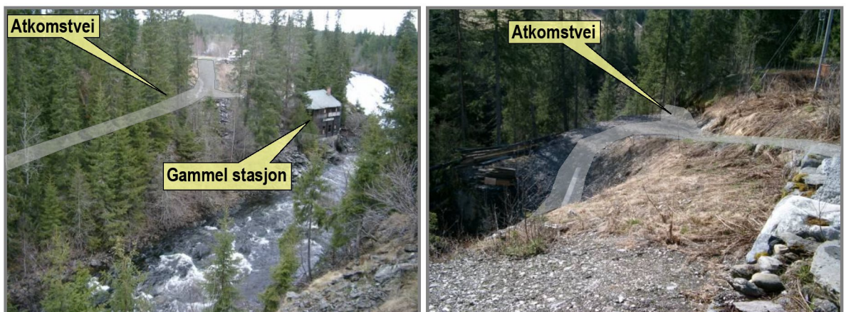
Figur 14 Venstre : Den gamle kraftstasjonen og trasé for atkomstvei til ny kraftstasjon. Høyre : Øvre del av atkomstvei sett fra toppen av platået i retning mot ny kraftstasjon. Mot venstre går den i dag mot den gamle stasjonen. Mot høyre vil ny vei fortsette mot den nye stasjonen.
