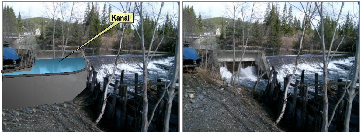
Figur 11 Venstre: Eksisterende overløpsterskel i Vala og forenklet illustrasjon av inntakskanal mellom bjelkestengsel og inntakt. Høyre: Eksisterende overløpsterskel i Vala. Dagens situasjon.
