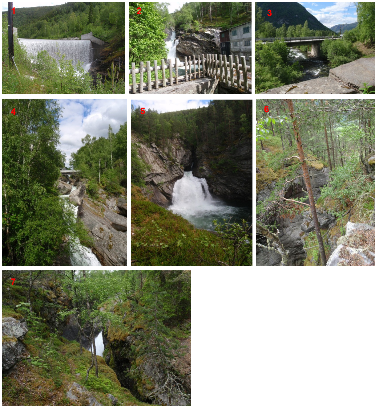
Bilde 1. Bilder tatt langs befaringsruta. 1) Eksisterende betongdam ved inntak for alternativ 1, 2) Foss og nedlagt kraftstasjon ved E6 (eneste elvestrekning som berøres ved begge alternativer), 3) Fra gammel kraftstasjon mot E6, 4) Strekning oppstrøms øverste foss, østover mot veien, 5) Foss like oppstrøms inntak for alternativ 2, 6 og 7) Bekkekløft.
