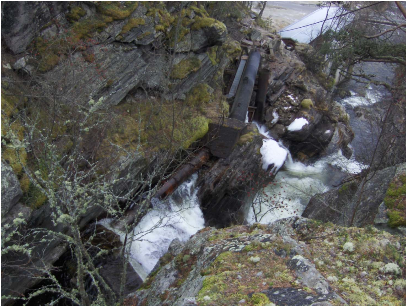
Fra Dam Ulafossen til kraftstasjon. Ny rørgate vil følge eksisterende rørgate på bildet. Ny kraftstasjon bygges like nedstrøms eksisterende. (alternativ 2)
