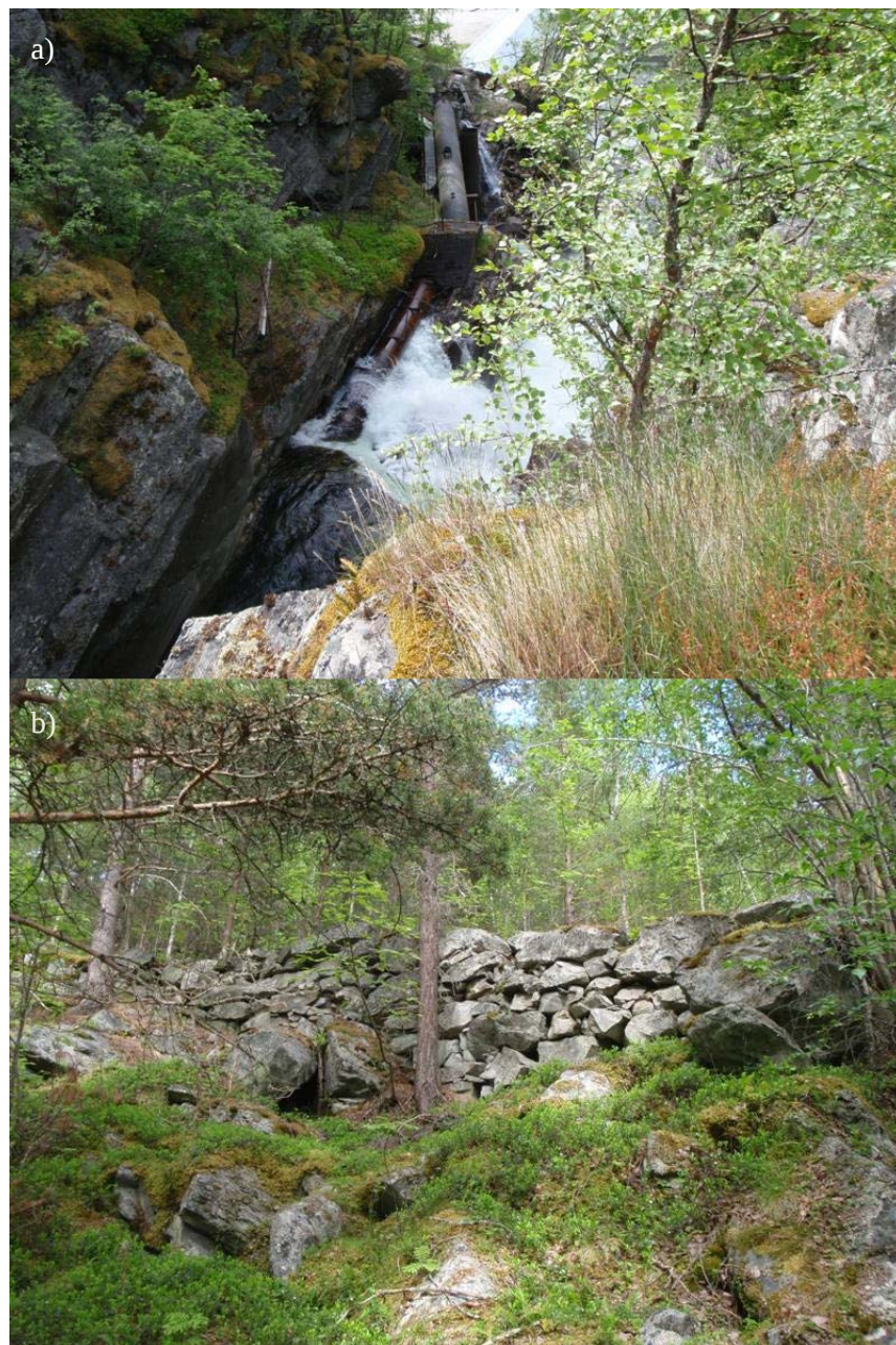
Figur 3-4 a) Den defekte rørgata til det gamle kraftverket midt i bildet. b) Veimur som ble laget i forbindelse med den gamle seterveien til Mysuseter som går langs nordsiden av Ula på prosjektrekningen.
