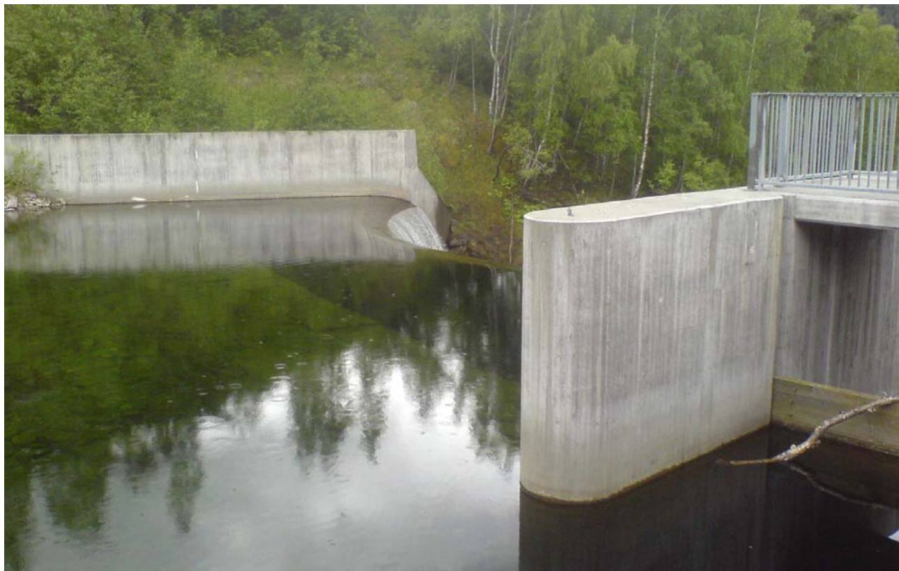
Oppstrøms side av inntaksdam for hovedalternativ
