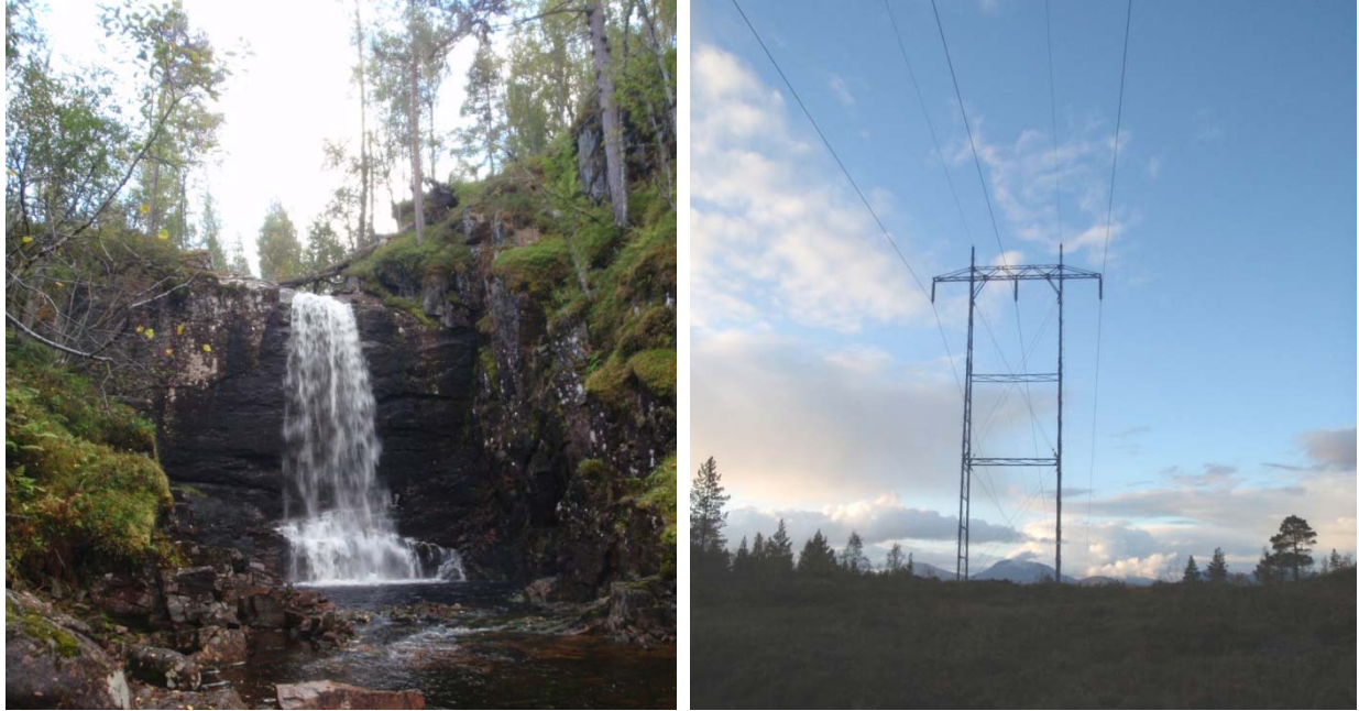
Figur 3.6 Elementer i landskapet. Venstre bilde: Foss med noe inntrykksstyrke. Høyre bilde: Dominerende kraftlinje
