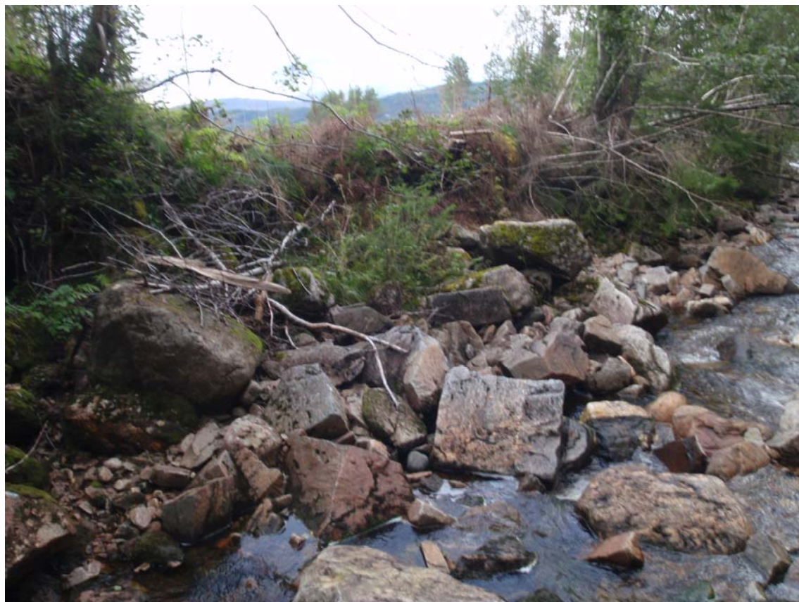
Bilde 7: Kraftstasjonsområde sett fra Bordalselva
