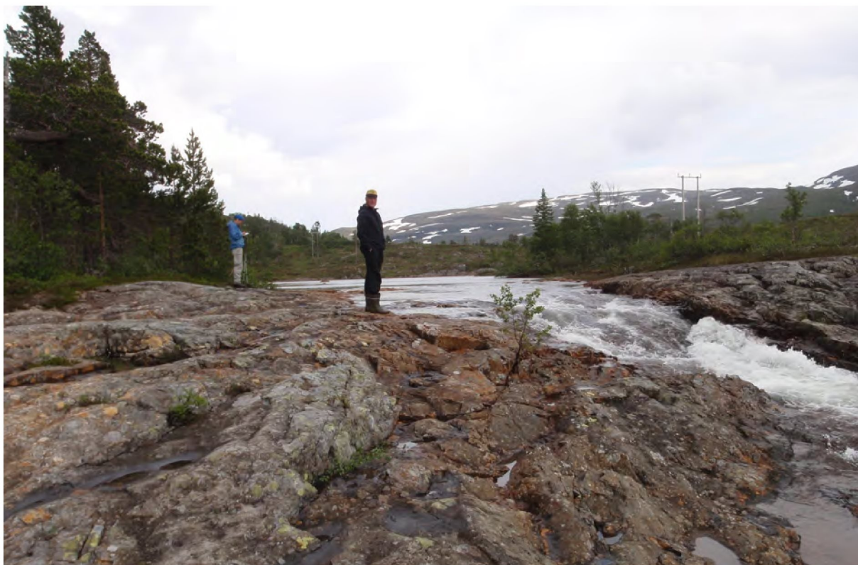
Figur 12 Damsted. Dato: 20. juni 2011. Beregnet vannføring på tidspunktet: ca. 1,2 m 3 /s (altså omtrent middelvannføring som er 1,17 m 3 /s). Foto: Solveig Angell-Petersen.
