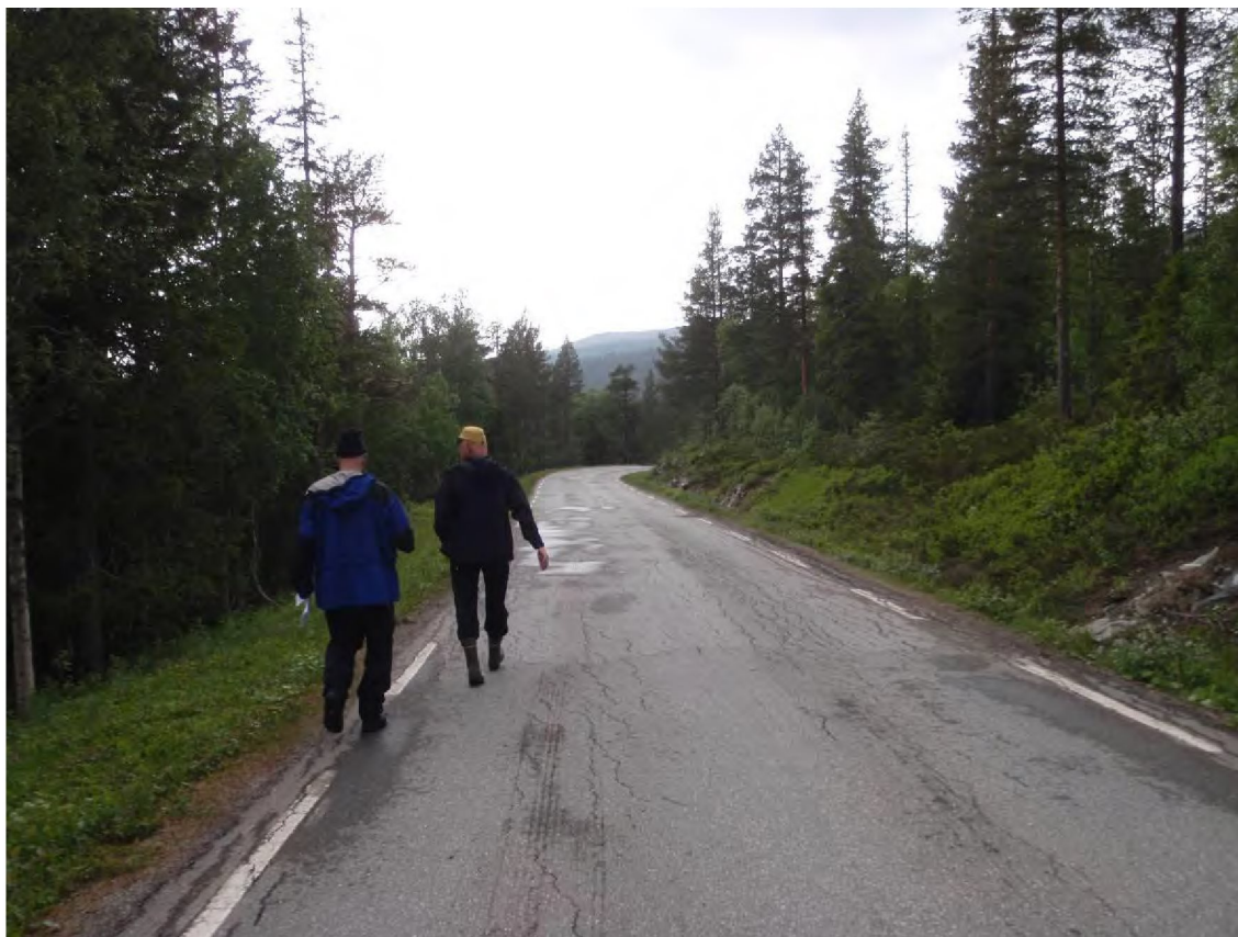
Figur 9 Vannveien graves ned på venstre sida (på bildet) av FV 764. Dato: 20. juni 2011. Foto: Priska Hiller.
