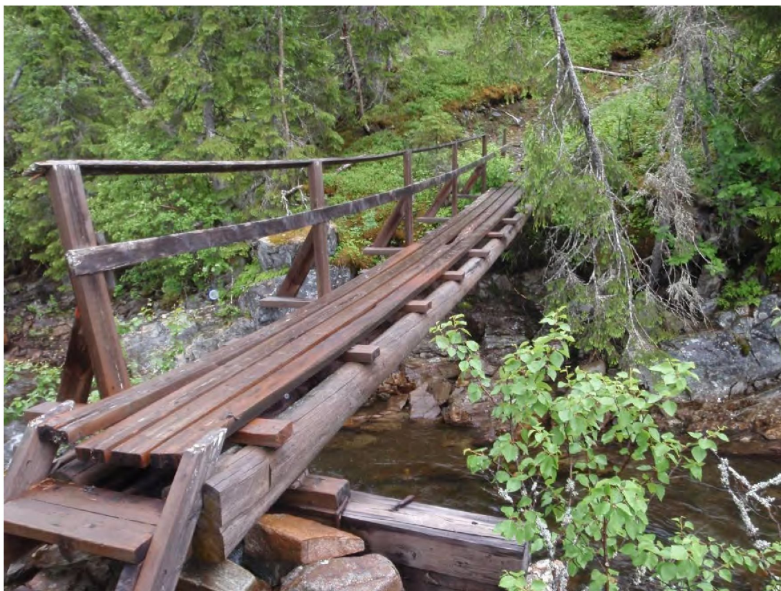
Figur 22 Eksisterende gangbru over Skorovasselva. Dato: 21.06.2011. Foto: Priska Hiller.
