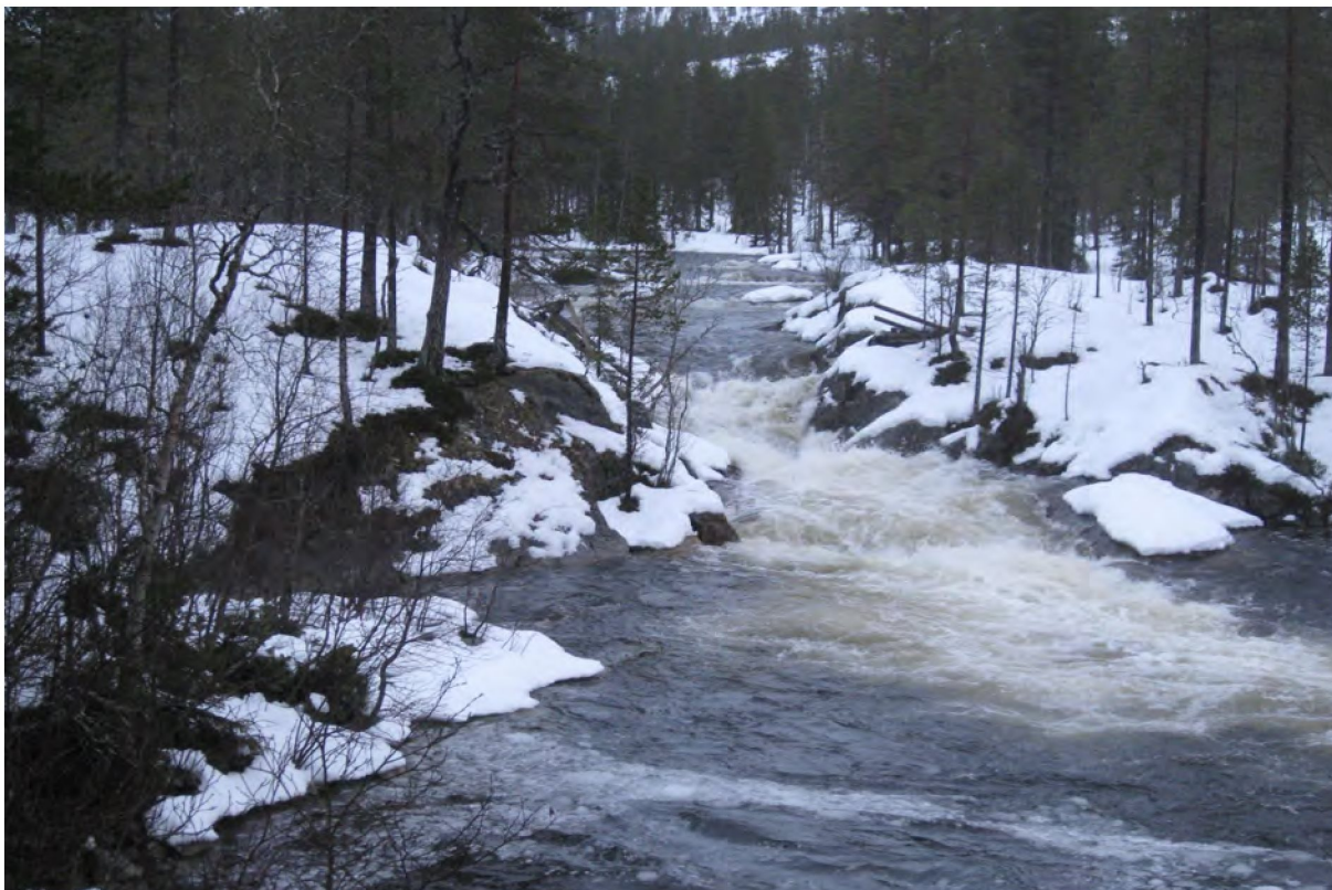
Figur 35 Grøndalselva ved planlagt kraftstasjon (rester av gangbru hvorfra bilde ble tatt 23. juni 2011, sees på sidene av elva ved stryket). Dato: 20. desember 2015. Beregnet vannføring på tidspunktet: ca. 20 m 3 /s. Foto: Knut Berger.
