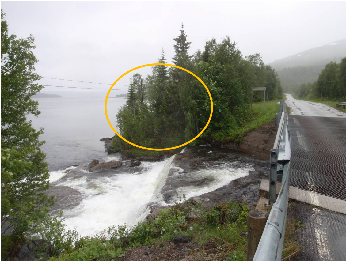
Figur 15 Fossen nedstrøms FV 363 og utløp av Røyrvasselva til Tunnsjøen. Planlagt kraftstasjonsområde i oransje oval
