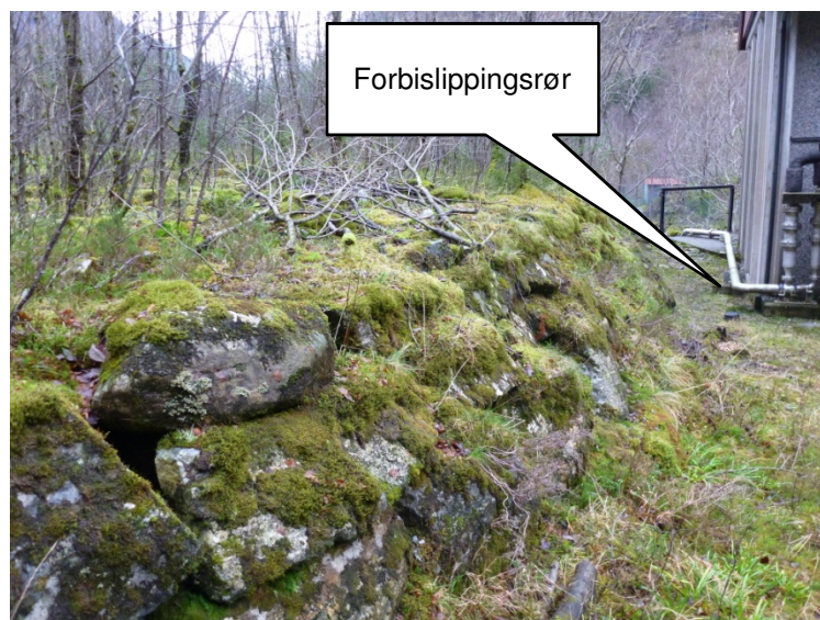
Bilde 2: Tomt for tilbygg til Hommelfossen kraftverk. Dagens forbislippingsrør vises til venstre for bygget. Dette er tilkoblet tilløpsrøret og går utenom aggregatet i kraftstasjonen
