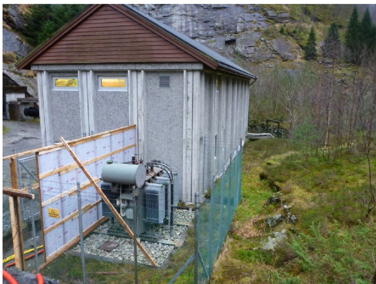
Bilde 3: Hommelfossen kraftverk. Tilkomstvei til tilbygget og mulig massedeposering til høyre for stasjonen
