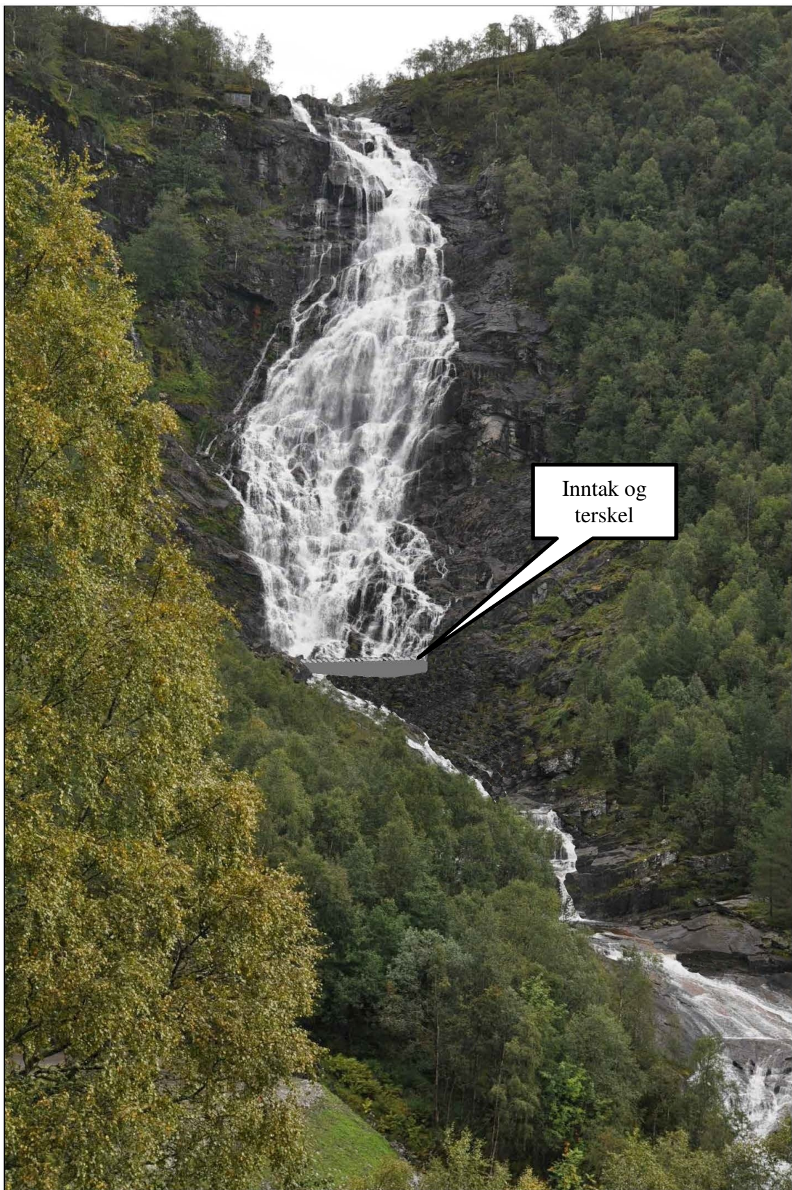
Bilde 3: Brydalsfossen sett fra fylkesveien, med illustrasjon av inntak og redusert vannføring nedstrøms inntaket. Oppstrøms fossen er det 1 m 3 /s. Nedstrøms fossen vil det på sommeren være 200 l/s.
