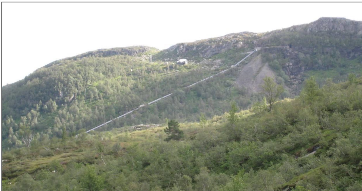
Figur 3 Rørgaten og tippet for vannveien til eksisterende Hodnaberg kraftverk (BKK). Sett fra Møyåni.
