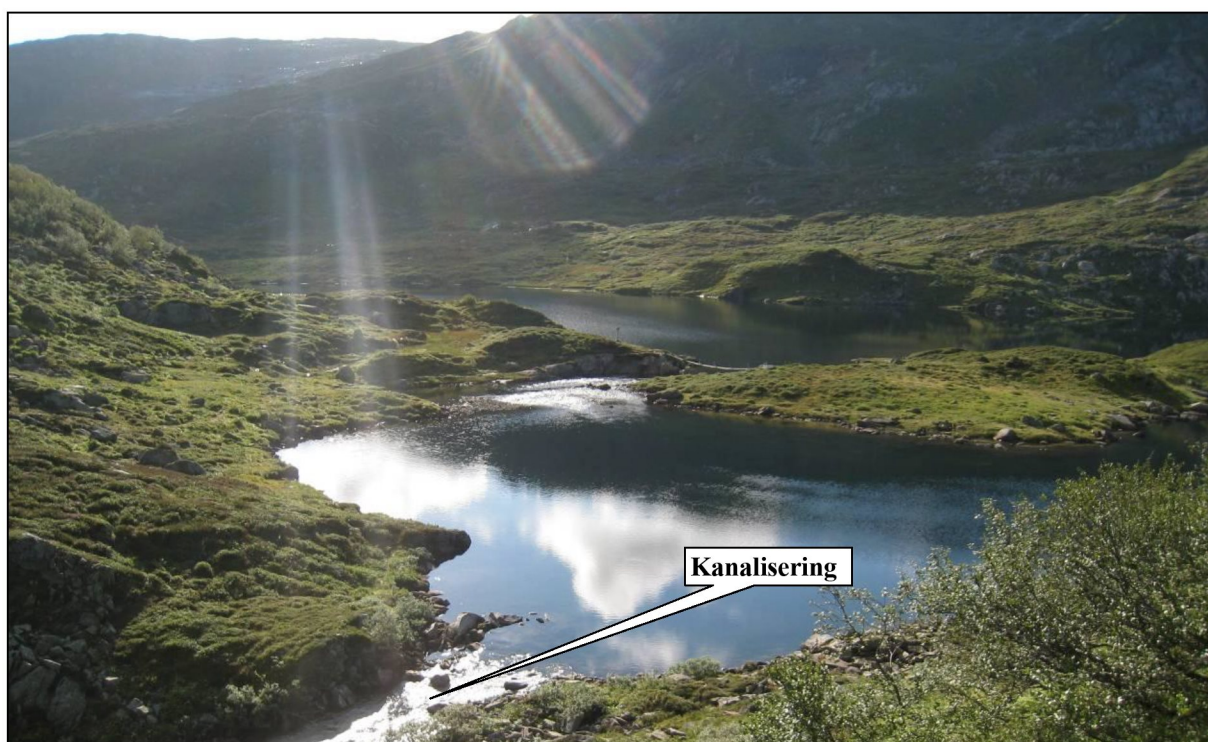
Figur 12 Inntaksbassenget reguleres med \pm 0,5 m. Det kanaliseres noe i utløpet mot dammen.
