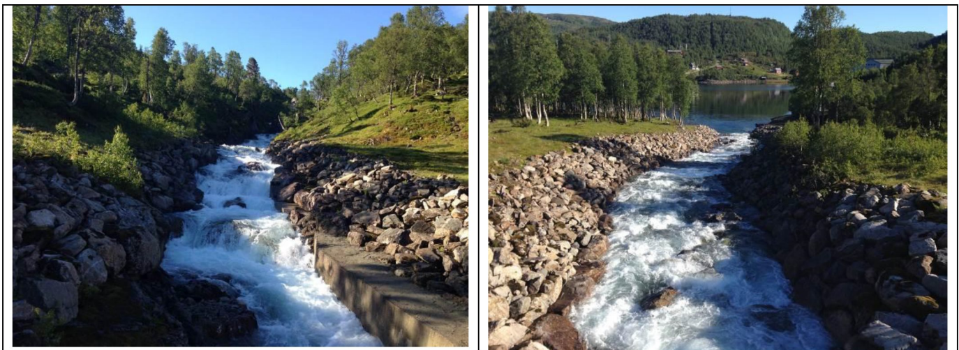
Figur 25 Møyåni ved en vannføring på ca. 2,2 m 3 /s (1.7.2014). Oppstrøms utløpet i Hamlagrøvatn.
