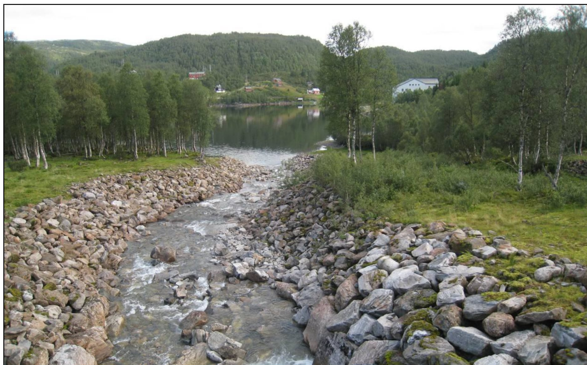
Figur 23 Ved utløpet av Møyåni i Hamlagrøvatn er det erosjonssikret, samt at elveløpet er rettet ut.
