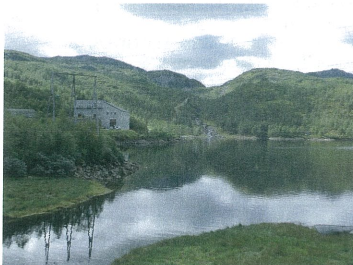
Møyani sett frå motsett side av hamlagrøvatnet. Hodnaberg kraftverk til venstre i bildet.
