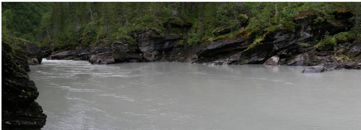
Figur 2 Bilde fra kraftstasjonsområdet. Panorama oppstrøms elva fra vestsiden av elva.
