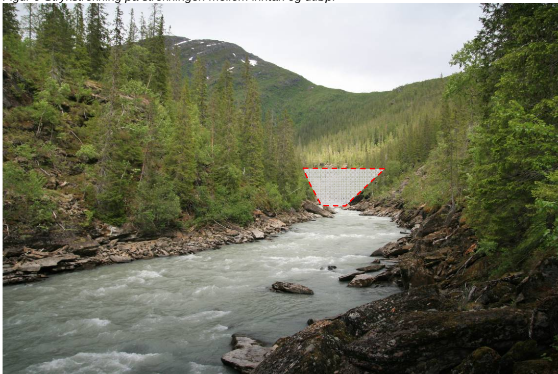
Figur 10 Inntaksområdet. Inntaket vil bygges veiløst. Atkomst i anleggsperioden vil foregå gjennom tunnelen som drives fra kraftstasjonsområdet i sør. Inntaksdammen som er antydnet på bildet over vil være ca 7 meter høy og ca 30 meter bred. På bildet over vil den være delvis skjult bak terrenget til venstre i bildet. Vannføringen i elva nedstrøms inntaksdammen vil reduseres.
