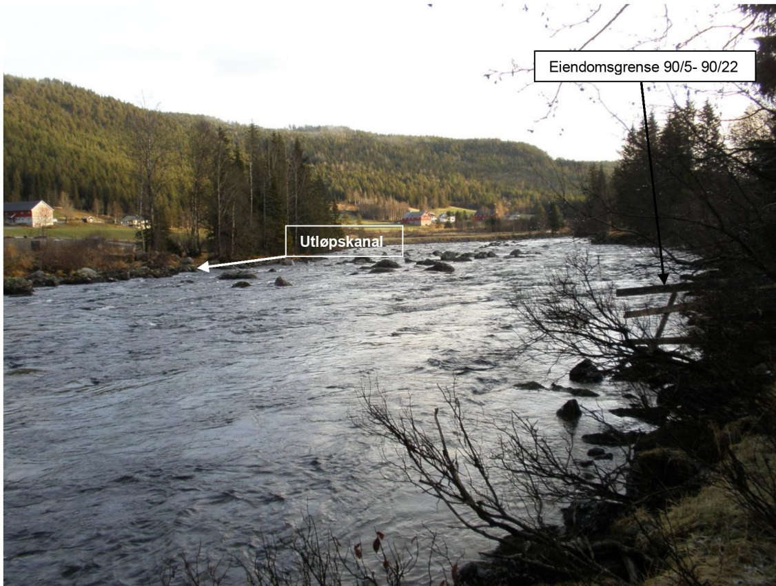
Figur 16 Elvestrekning ved utløp (vannføring ca. 9,5 m 3 /s)
