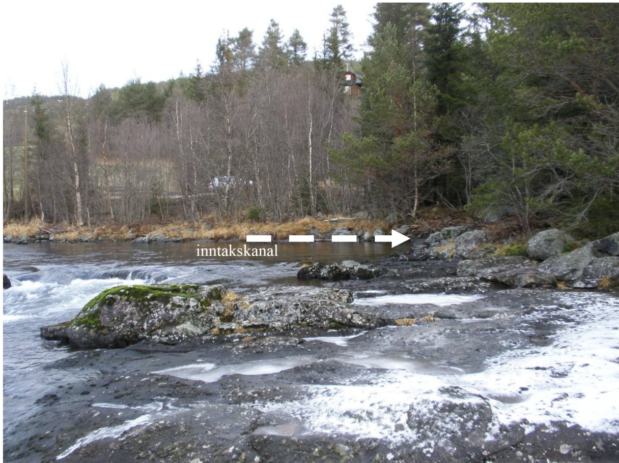
Figur 3 Rett nedstrøms inntakssted (24.11.2011, vannføring ca. 9,5 m 3 /s)
