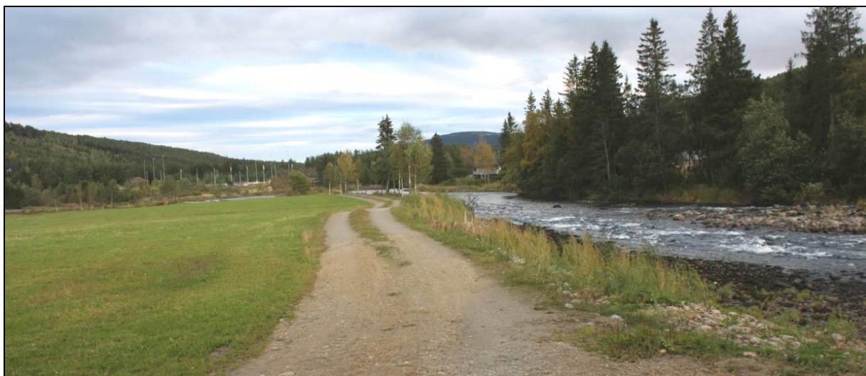
Figur 23. Føssaberge kraftverk tilknyttes 22 kV-nettet via en ca. 700 m kabel som graves ned langs elvekant og gårdsvei østover til Tveit nettstasjon.
