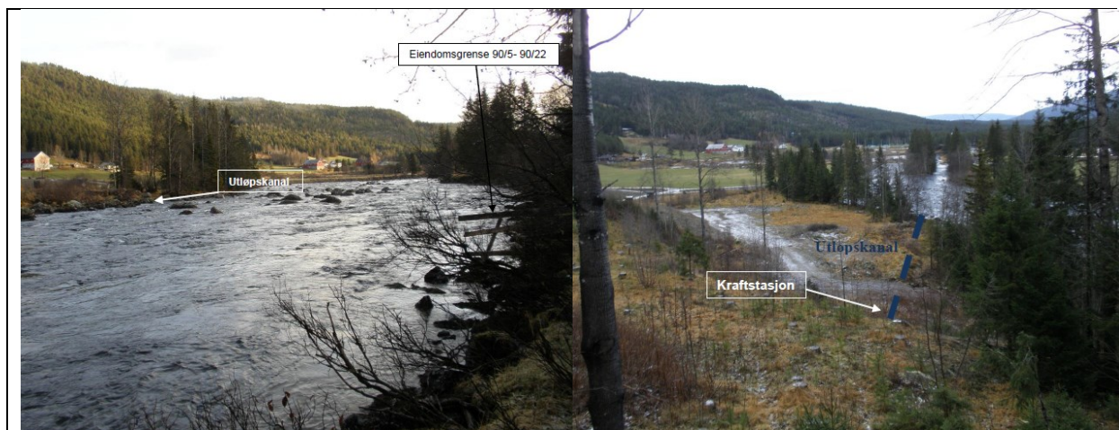
Figur 6: Bilder viser området for planlagt kraftstasjon og utløpskanal ved Føssaberge kraftverk. Idrettsanlegget på Tveit skimtes i bakgrunnen på høyre bilde.
