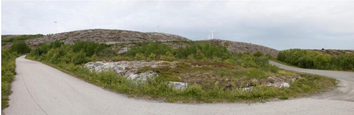
Figur 11: Adkomstvei til Vikna vindmøllepark fra Fv508 (Foto: Ask Rådgivning)
