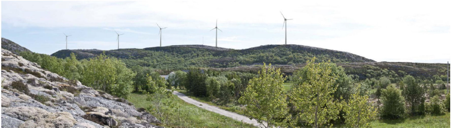
Alternativ 2. Montering av fem nye vindturbiner á 0,9 MW.
