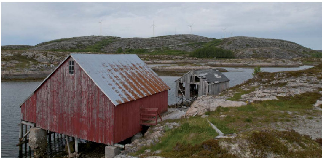
Alternativ 2. Montering av fem nye vindturbiner á 0,9 MW.
