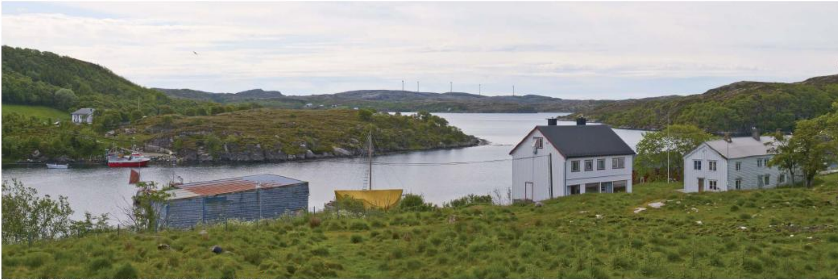
Alternativ 2. Montering av fem nye vindturbiner á 0,9 MW.
