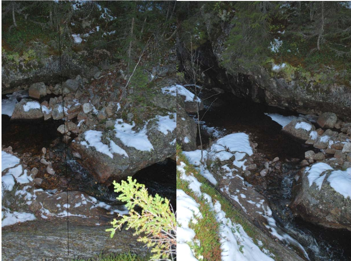
Inntak i Gyltebekken
