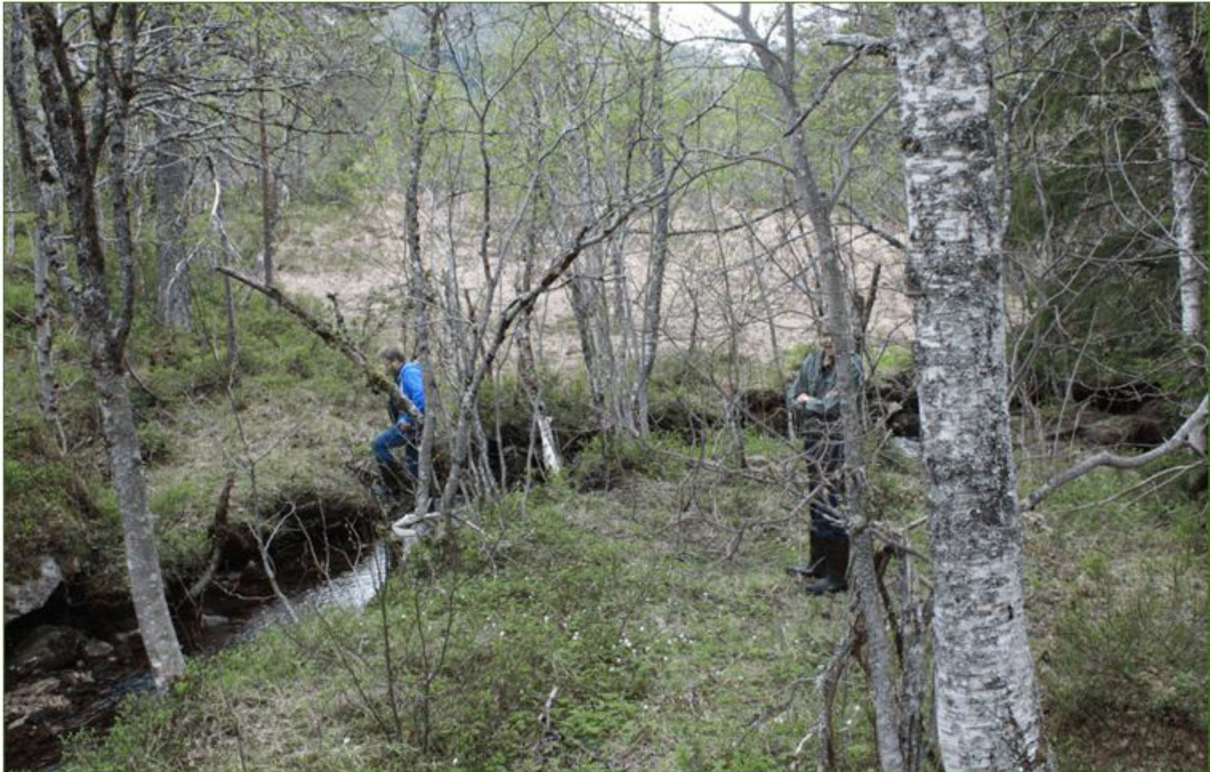
Foto viser Raudgrovmyrbekken, rørtrase til høyre i bildet
