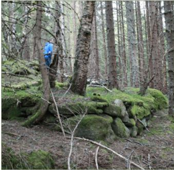
Figur 3.10.5 Grunnmuren til ei gamal utmarksløe.
