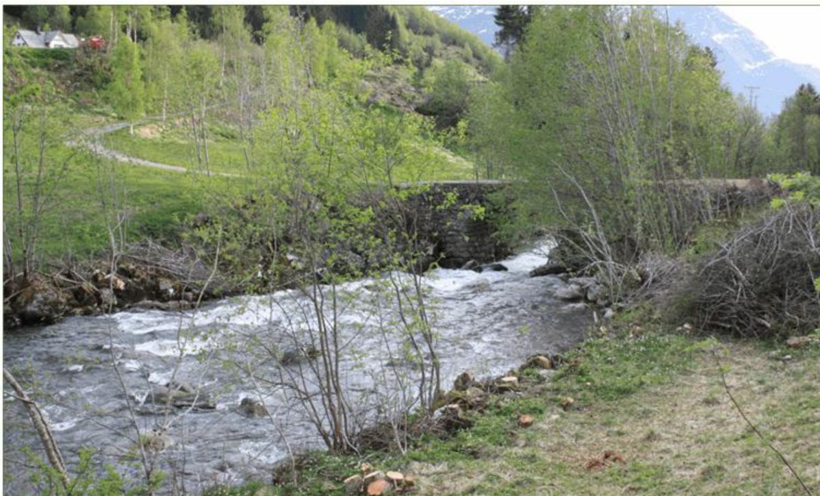
Foto viser Gamlebrua og nærmaste hus. Kraftstasjon på høgre side i framkant og utanfor bildet.
