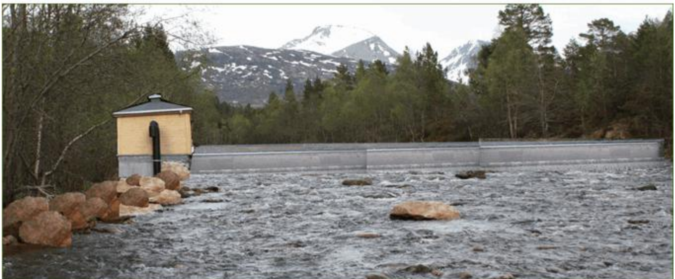
Figur 3.9.1 Fotomontasje som illustrerer eit coandainntak plassert på aktuell damstad.
