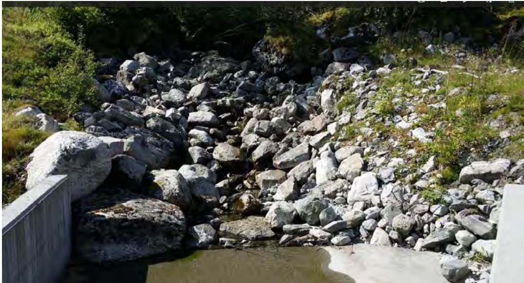
Foto 1. Liten/svært liten vassføring 27.07.2014. Estimert til 5 – 10 l/s. Foto i sidebekk like oppstrøms der trykkørøret kryssar sidebekken. Betongtrau for sikring av trykkørøret i framgrunnen.
