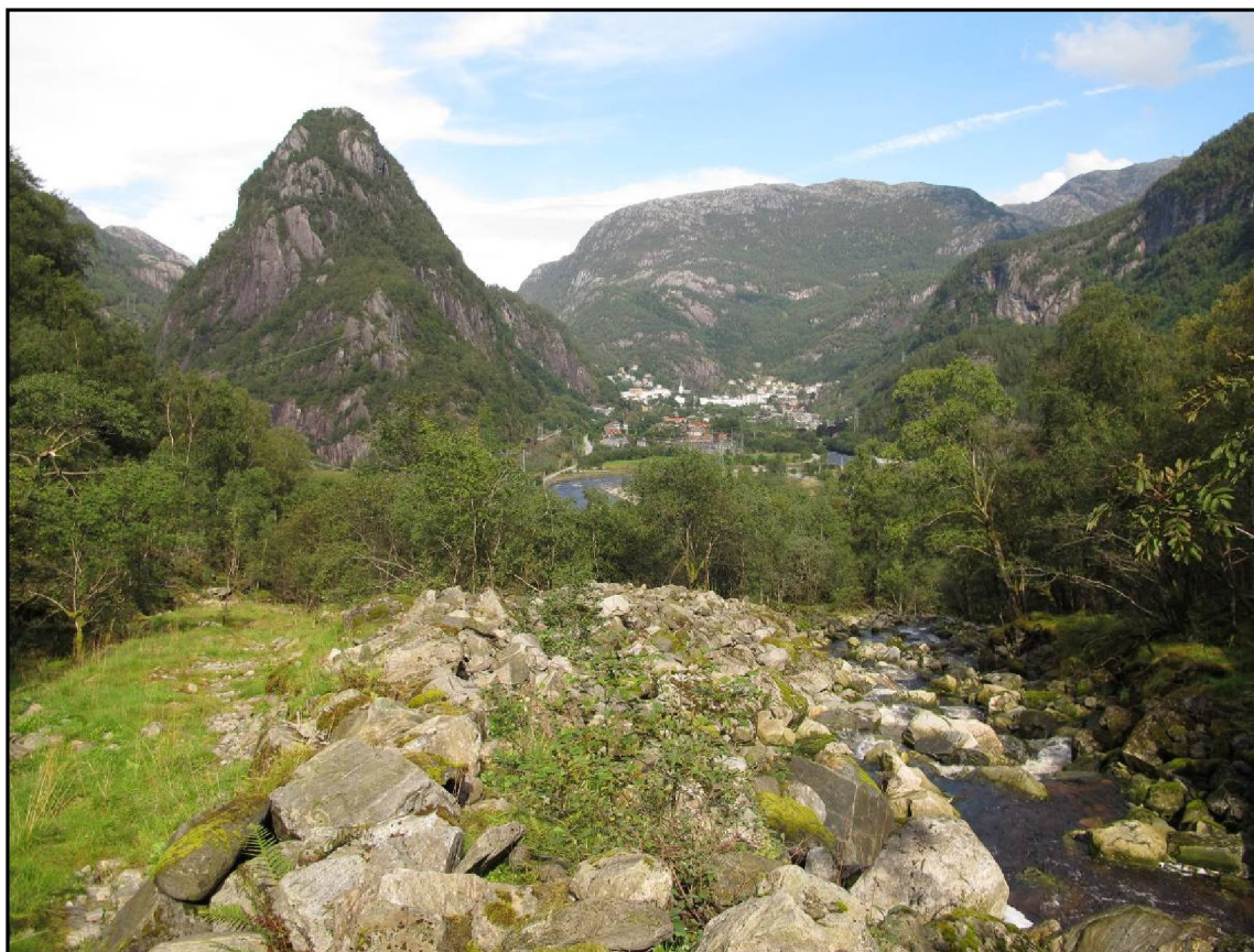
Figur 8. Nedre del av Moko er delvis kanalisert og det er også laget en traktorvei på vestsiden av elven. Foto: Bjarne Oddane.
