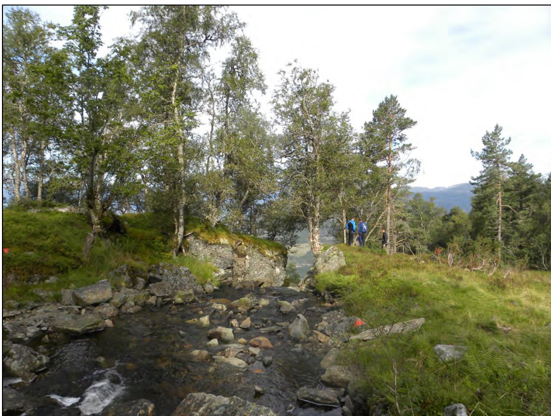
Bildet viser område for plassering av dam, sett fra oppstrøms side.
