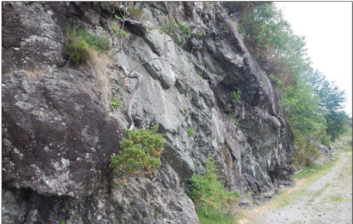
Foto 3. Område B: Eksempel på blokker som kan løsne.
