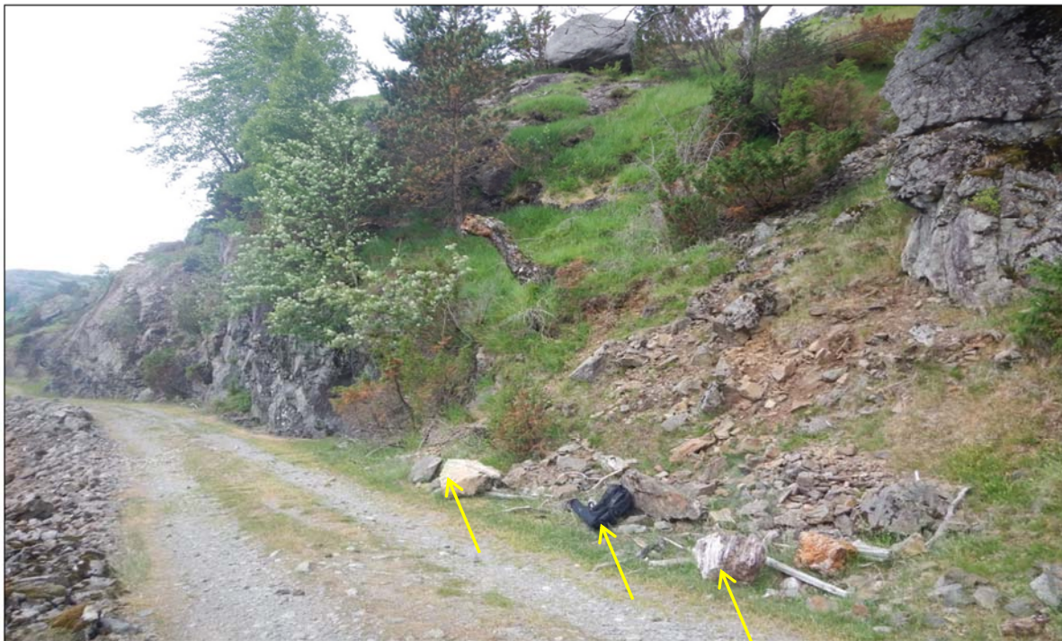
Foto 4. Område B: Eksempel på blokker som har rast ut.
