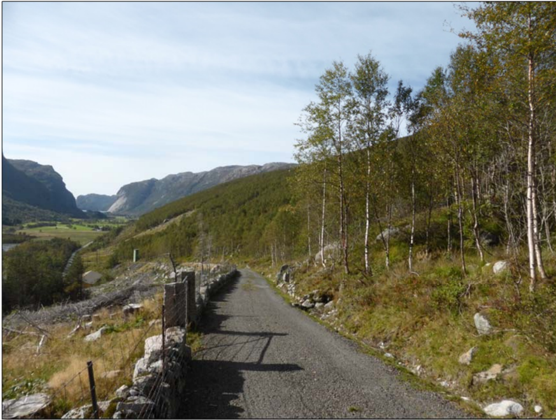
Figur 24. Ved Øvre Maudal, dalen med Maudalsvatnet i det fjerne.
