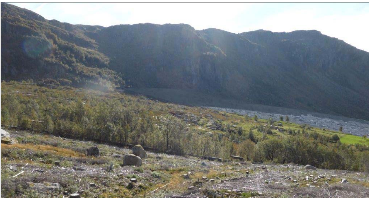
Figur 32. Deponi 1 Maudal, situasjon før og etter.
