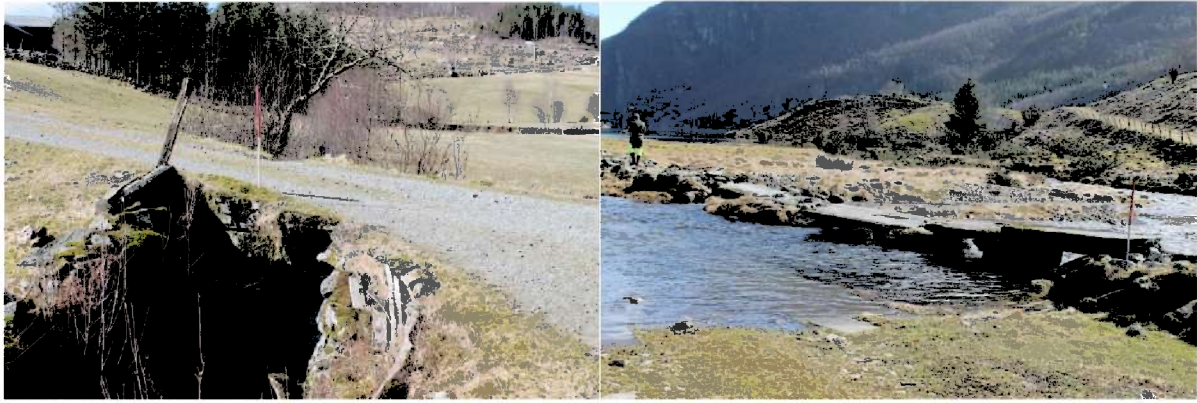
Figur 9 - Klopp 1 (t.v.) og Klopp 4 (t.h.)
