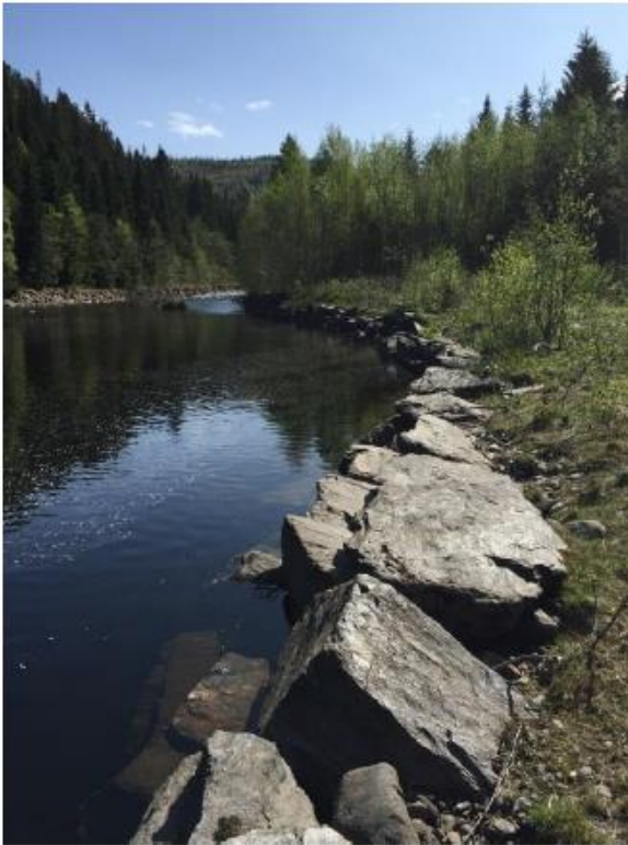
Figur 2-42 Renåa er delvis sikret i nedre del mot utløpet. Foto Statkraft 2016.
