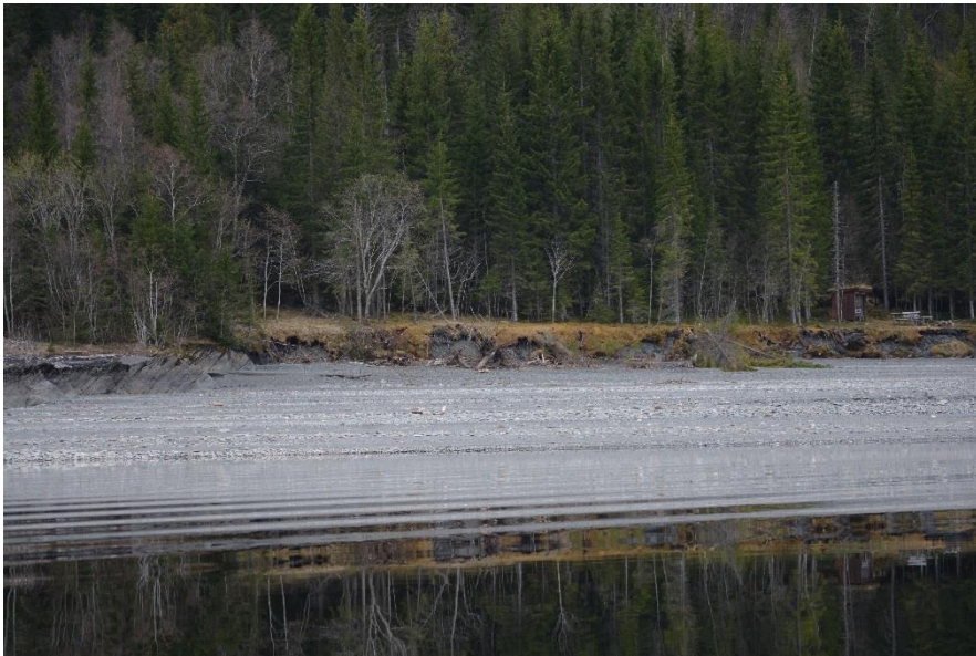
Figur 2-23 Erosjon på Sandodden. Foto: Statkraft 2017.
