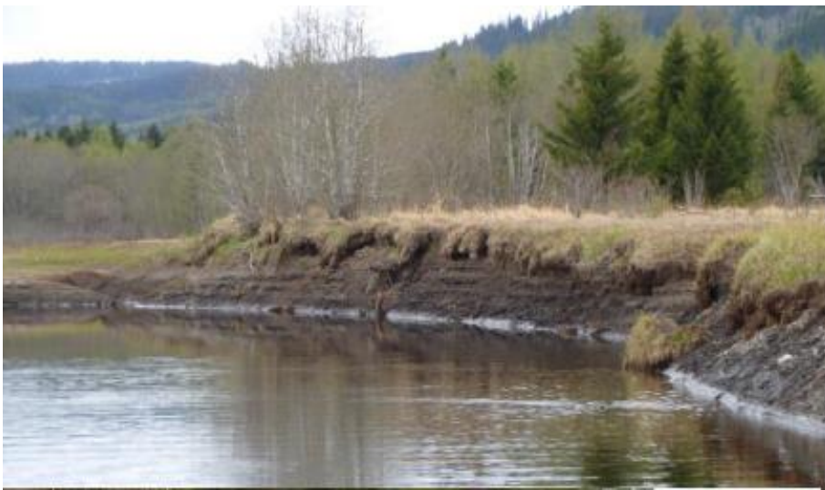
Figur 2-34 Små erosjonsskader i utløpsområdet fra Slindelva. Foto: Statkraft 2016.
