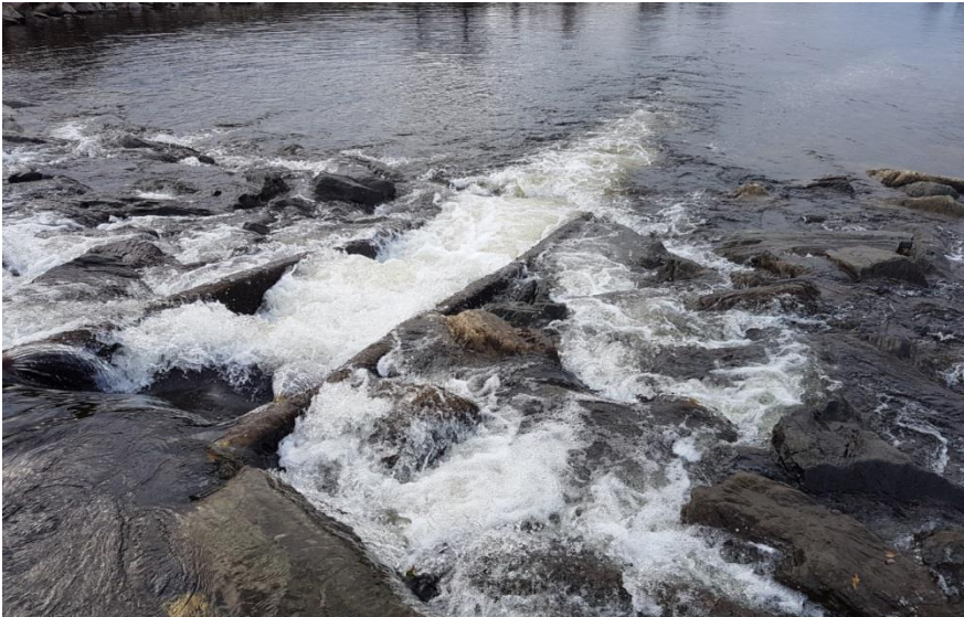
Figur 2-92 Fiskerenne i terskel ved utløpet av Garbergelva.
