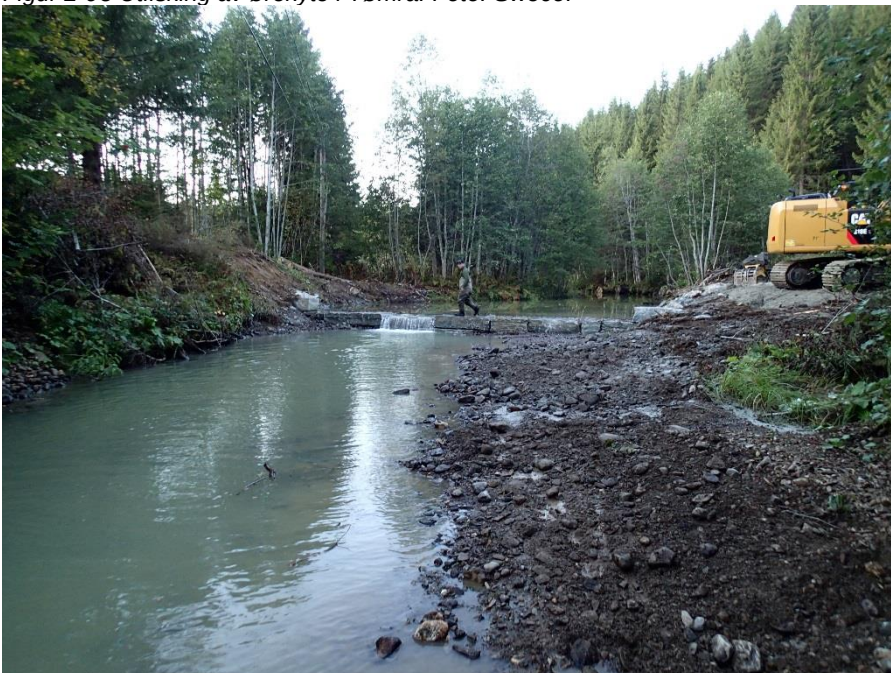
Figur 2-94 Etablering av fiskeperre i Tømra 2014. Foto: Sweco.
