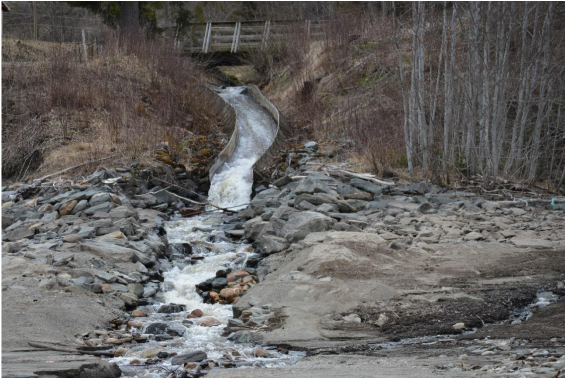
Figur 2-18 Trerenne veg Fosselv østre. Foto: Statkraft 2017.
