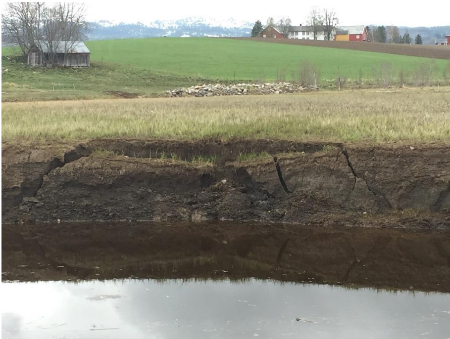
Figur 2-6 Utglidninger ved Sirum sør. Foto: Statkraft 2017.
