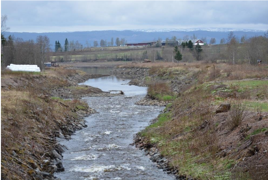
Figur 2-13 Tidligere sikring har glidd ut flere steder. Foto: Statkraft 2017.
