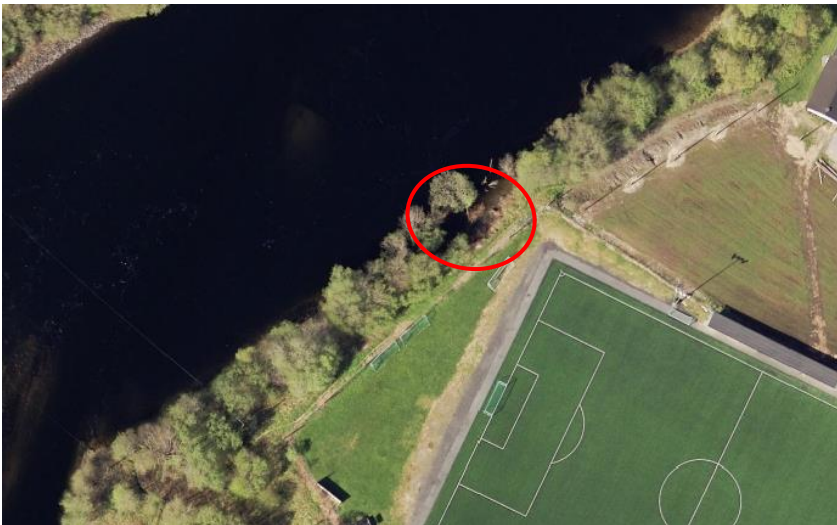
Figur 2-37 Liten erosjonsskade ved Selbu fotballbane. Flyfoto 2017.
