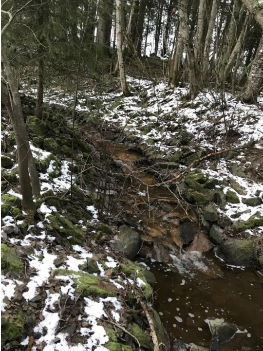
Figur 2-48 Sikret kanal i Uglanbekken.
