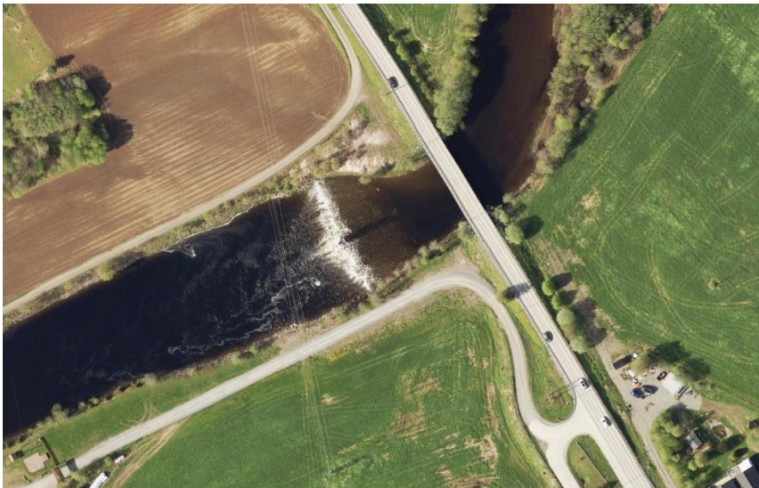
Figur 2-4 Terskel med fiskepassasje ved utløpet av Garbergselva, flyfoto 2017.
