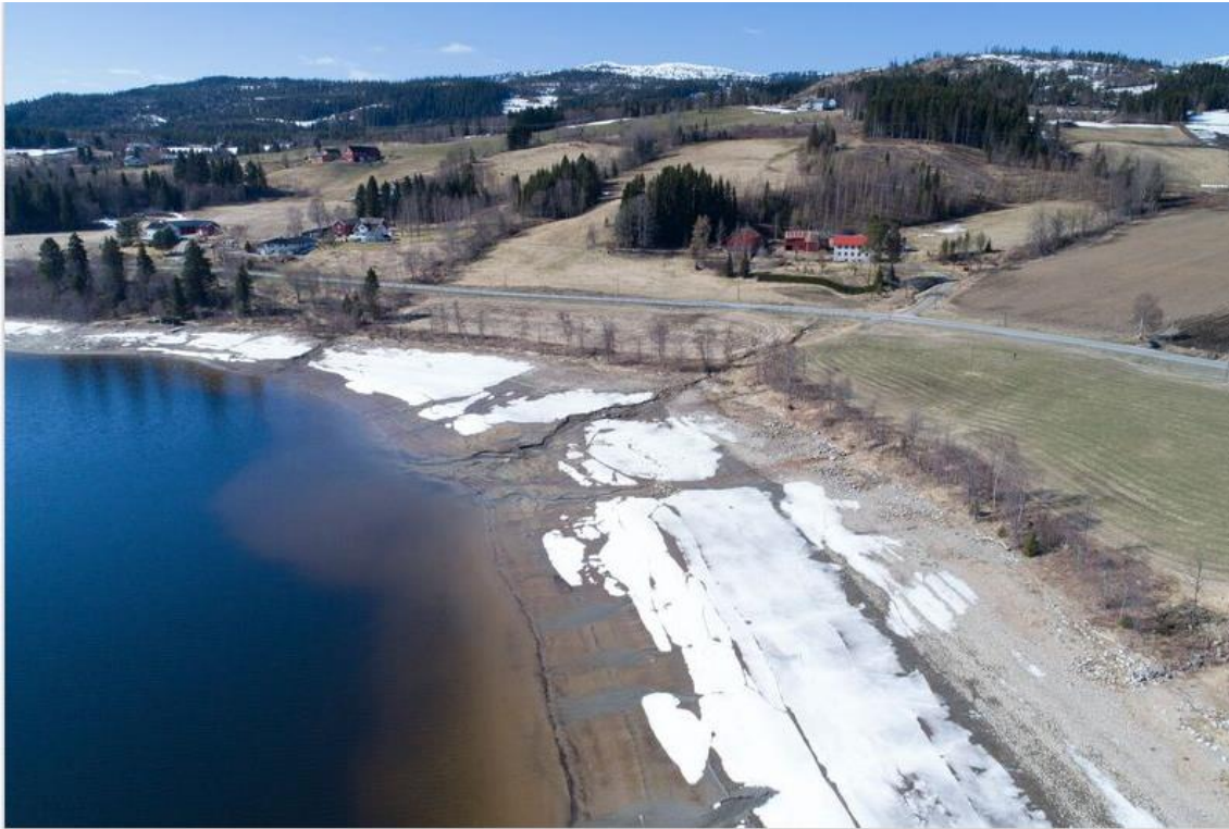
Figur 2-16 Dronefoto av området med utvasking av sand i strandsonen ved Stamnes, mai 2017. Vannstand 156,03.
