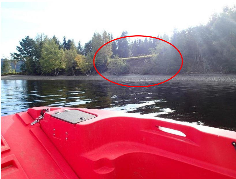
Figur 2-2 Erosjon på Flønes vist med rød ellipse. Foto: OKB
