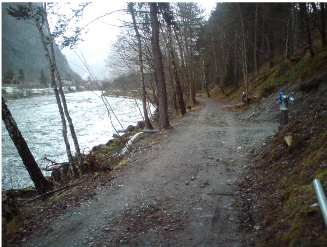
Figur 11. Brønn 1 sett fra nord. Utpumpet grunnvann ledes til elva.
