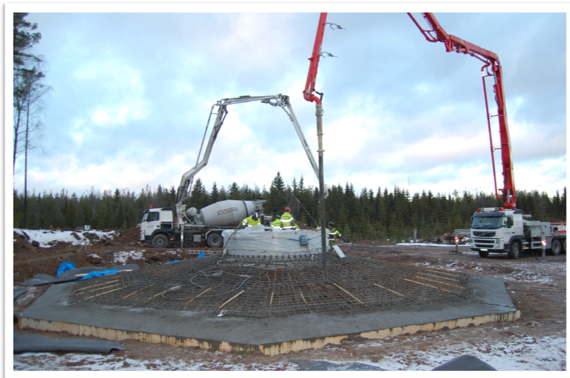
Figur 6-5 Støping av fundamnet Foto E.ON Vind
