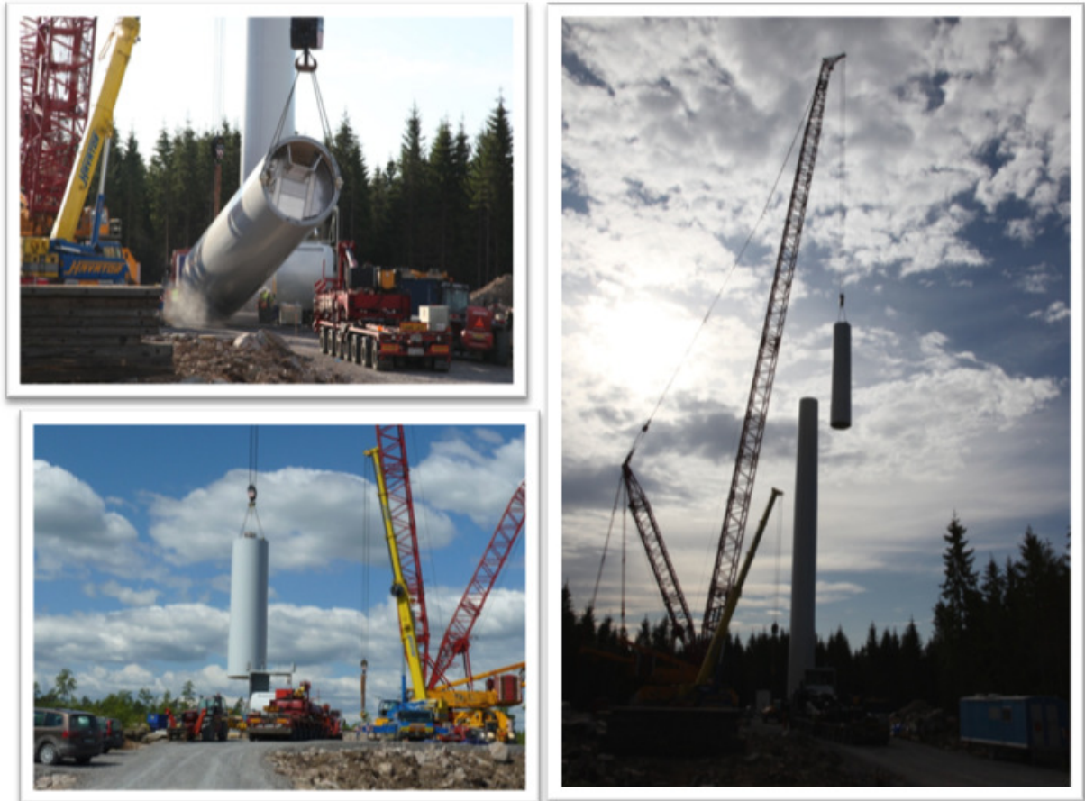
Figur 6-9 Montering av vindturbiner
