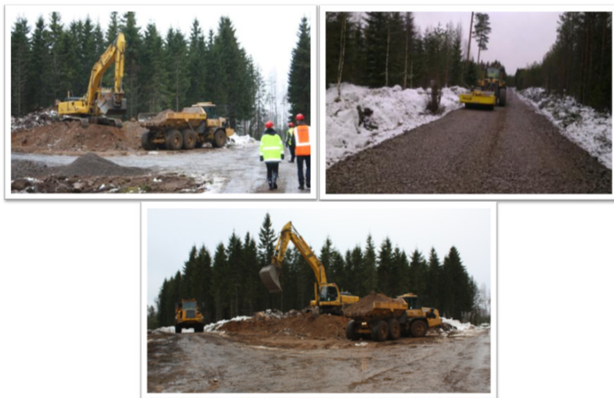
Figur 6-6 Fra bygging av veier i et svensk vindkraftverk. Bilde: E.ON
