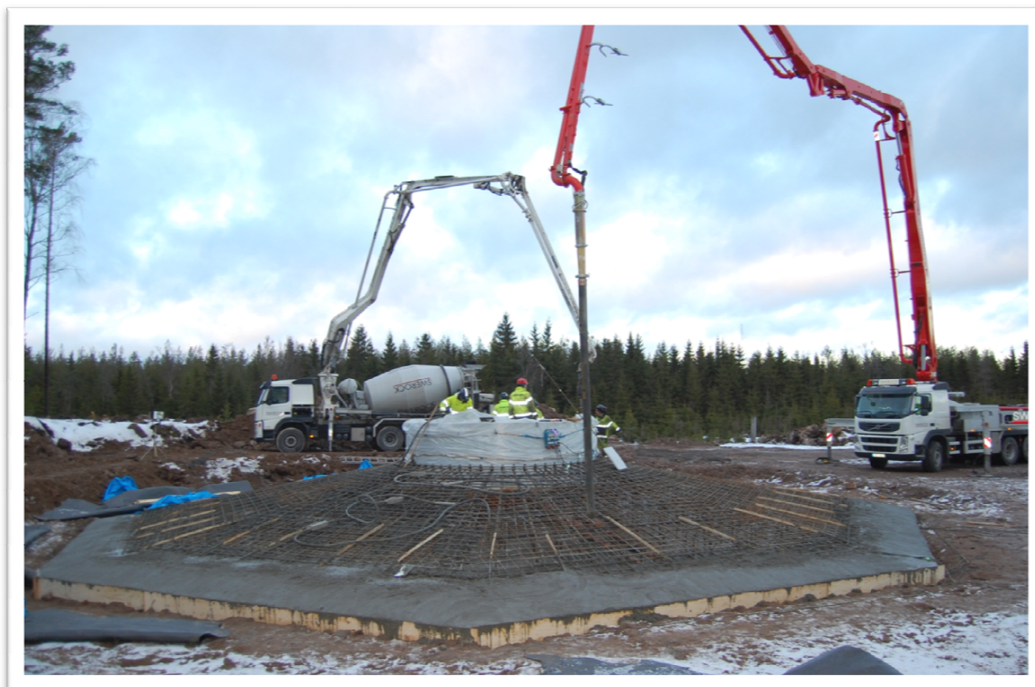
Figur 6-5 Støping av fundamnet Foto E.ON
