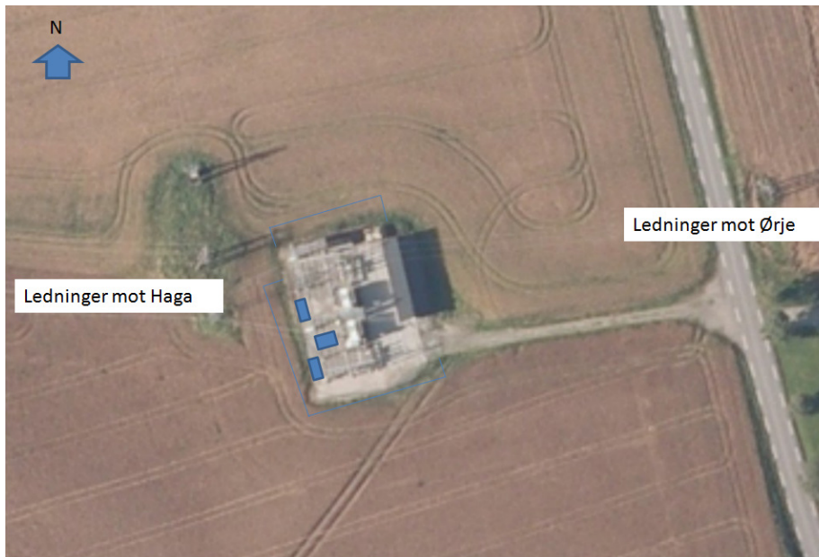
Figur 4-10 Aasgaard transformatorstasjon (kilde Norge i bilder), nye effektbrytere (blå firkant), Blå strek mulig utvidelse av gjerde
