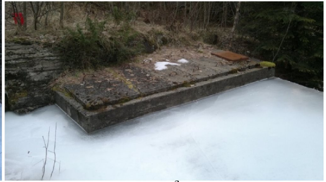
Inntakskammer ca. 3 m 3
