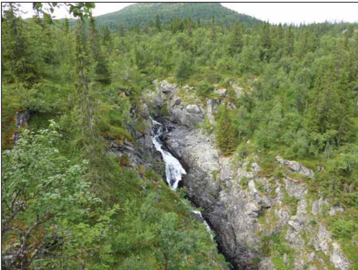
Figur 6 Alagilet – vassføring ca. 0,2 m 3 /s
