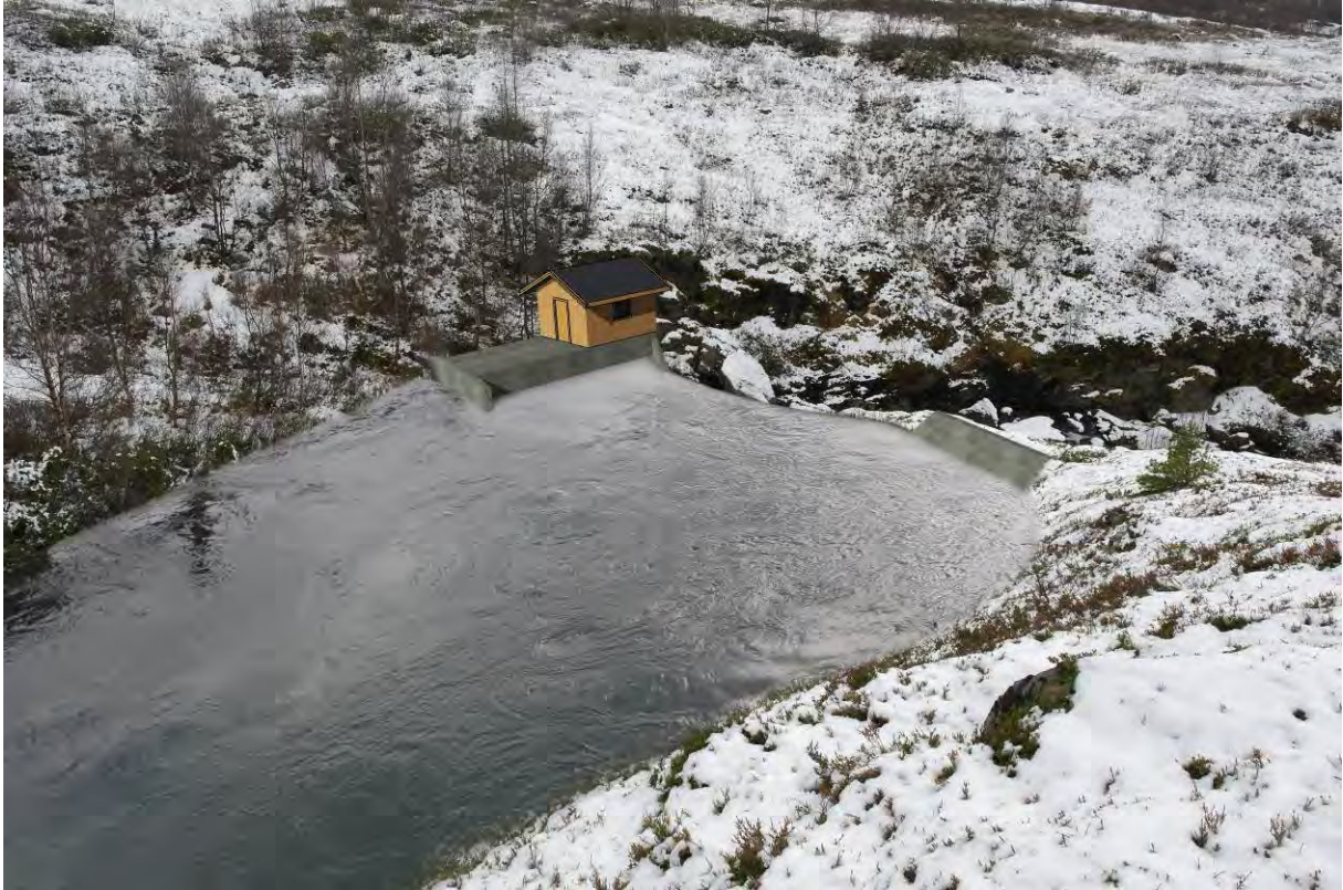
Illustrasjon som viser inntak og dam, sett medstrøms.
