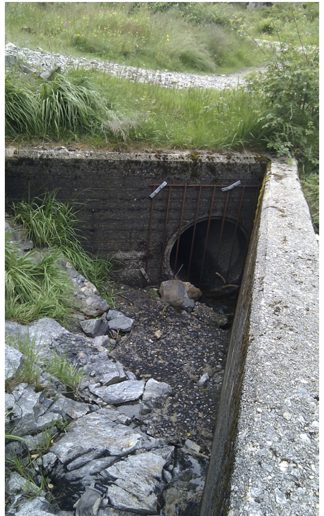
Overløpsrenne avslutning nede
