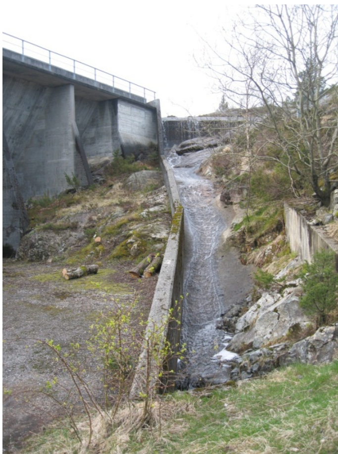
Bilde 4 Overløp ved dam
