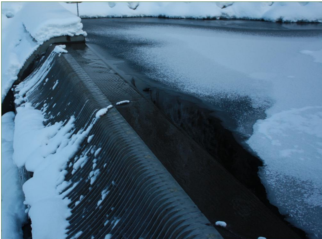
Figur 2.2.4.5 Coandainntak i drift ein kald vinterdag med låg vassføring.
