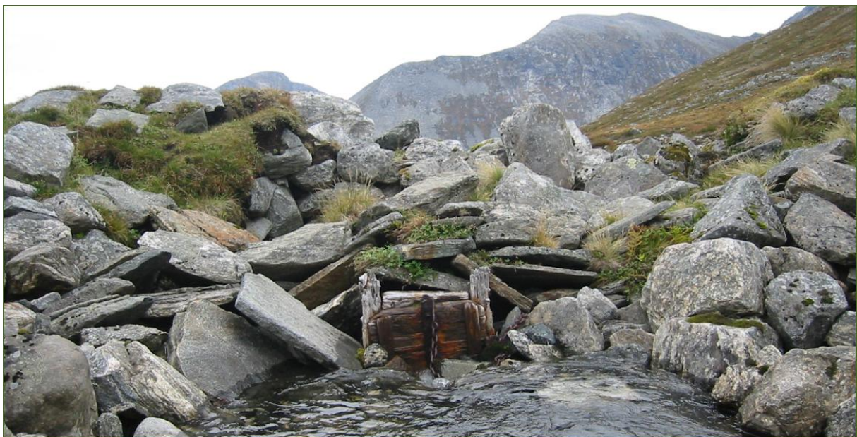
Figur 3.10.3 Fyllingsdam og restar av luke for vassregulering til gamle Vaksvik kraftverk ved Litlebotnvatnet.
