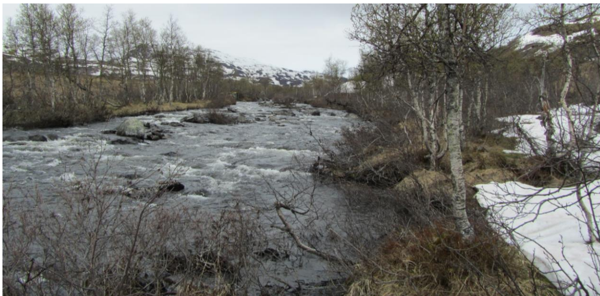
Område aktuelt for bygging av terskler opp mot planlagt inntaksdam, tursti til høyre i bildet.
