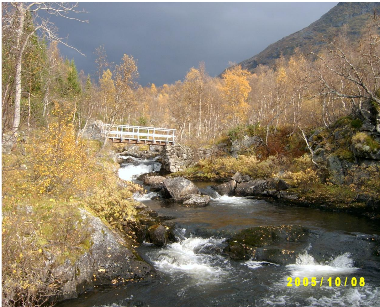
Gangbro over berørt del av Isdøla
