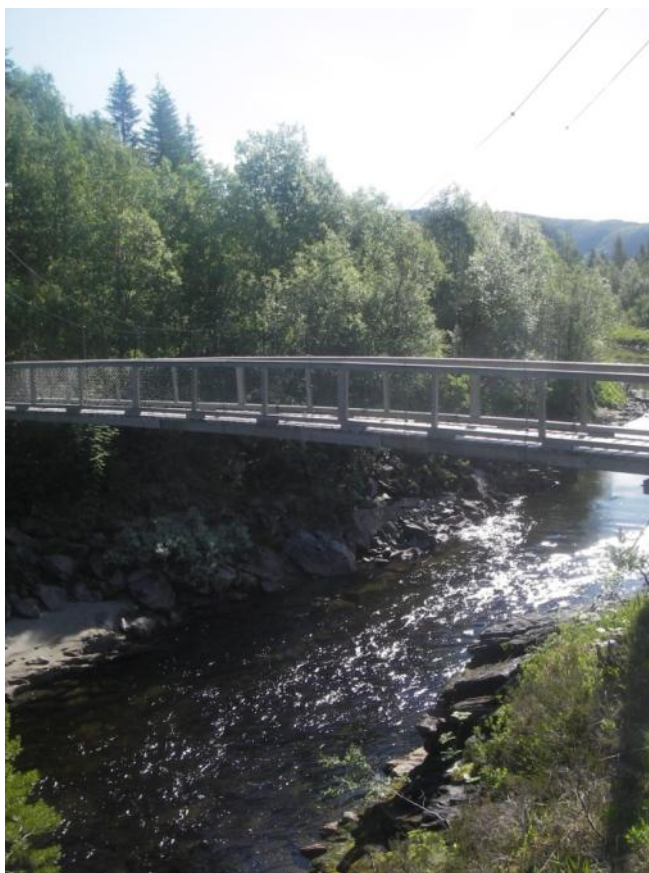
Figur 2.8 Eksisterende gangbro, oppstrøms planlagt inntak
