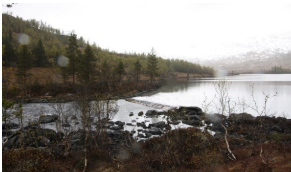
Visualisert terskel ved utløpet frå Storevatnet.
