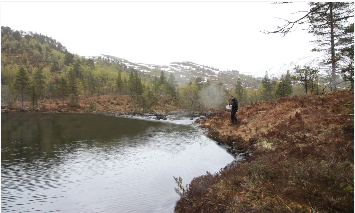
Figur 4-12 Visualisert terskel ved utløpet av Dalevatnet.
