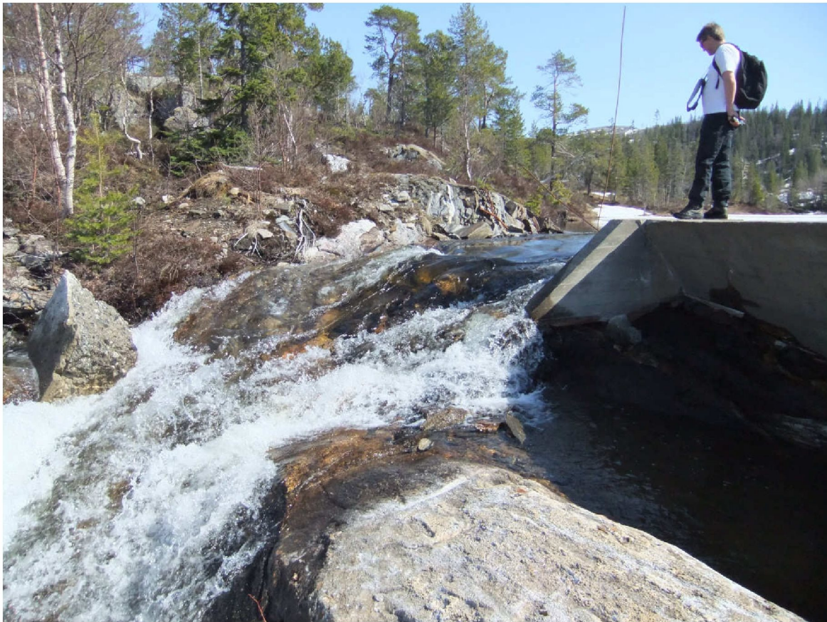
Bilde 05: Inntaksområde. Overløp fra eksisterende vannmagasin til vannverk
