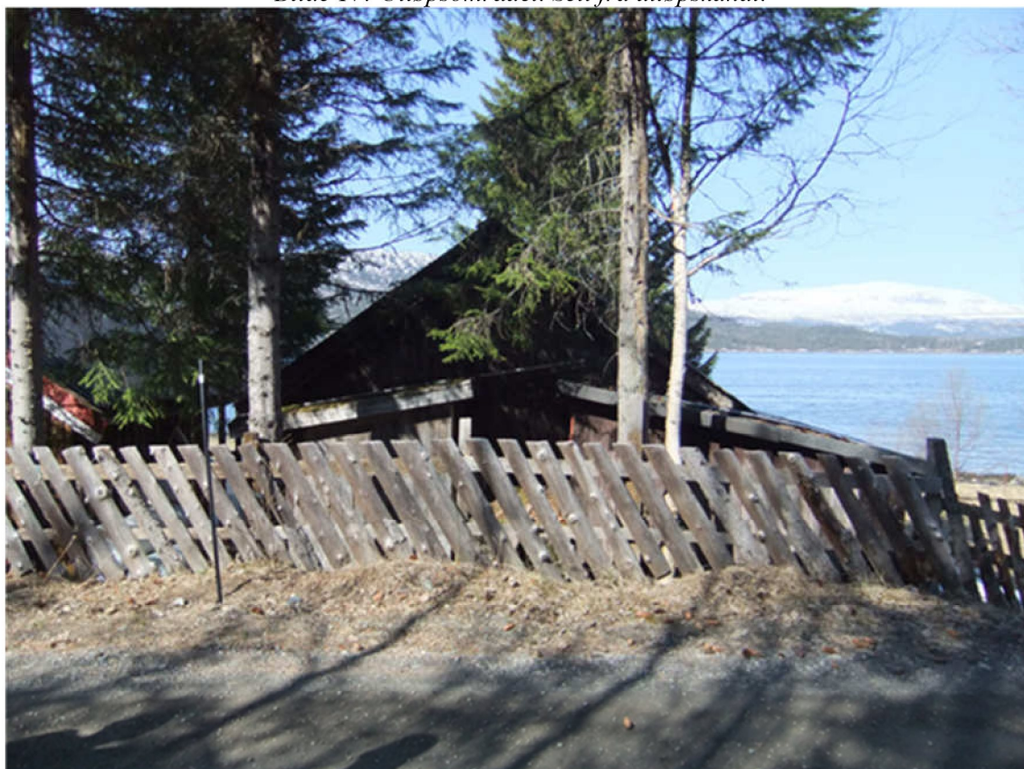
Bilde 18: Gamle kraftstasjon, nedsiden av veien.
