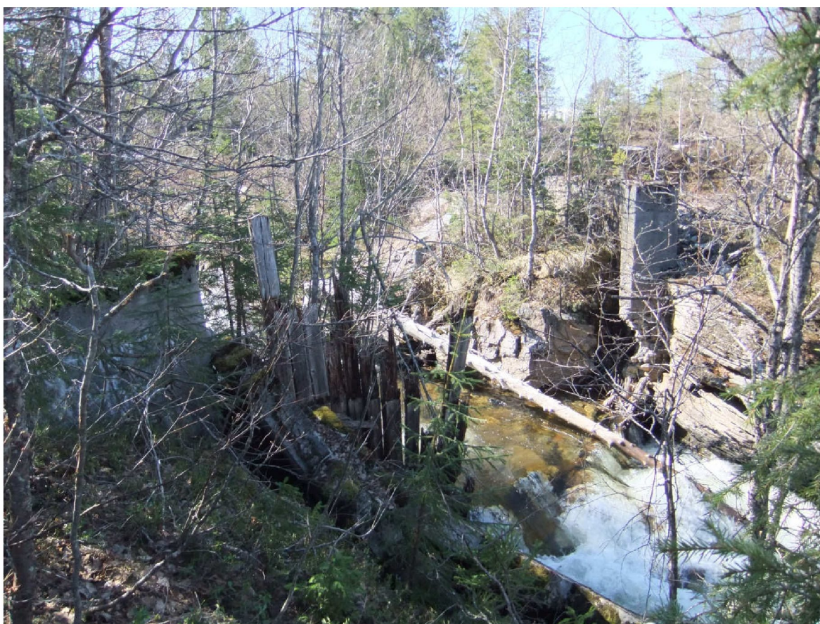
Bilde 12: Nedstrøms rest av gamle inntaksdam, på ca kote 100
