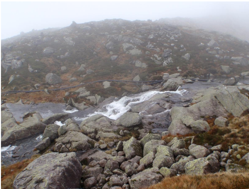
Figur 5 Hevertledninger fra Svartavatn
