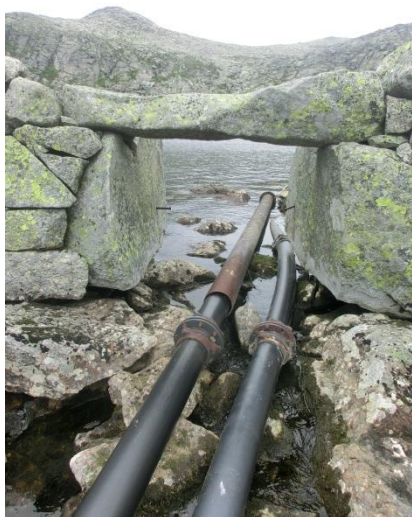
Figur 17. Foto av stemma ved Svartavatnet. Nederst til venstre er en åpning der det kan ha stått en port som kunne lukkes og åpnes. Alle foto: Asplan Viak as.
