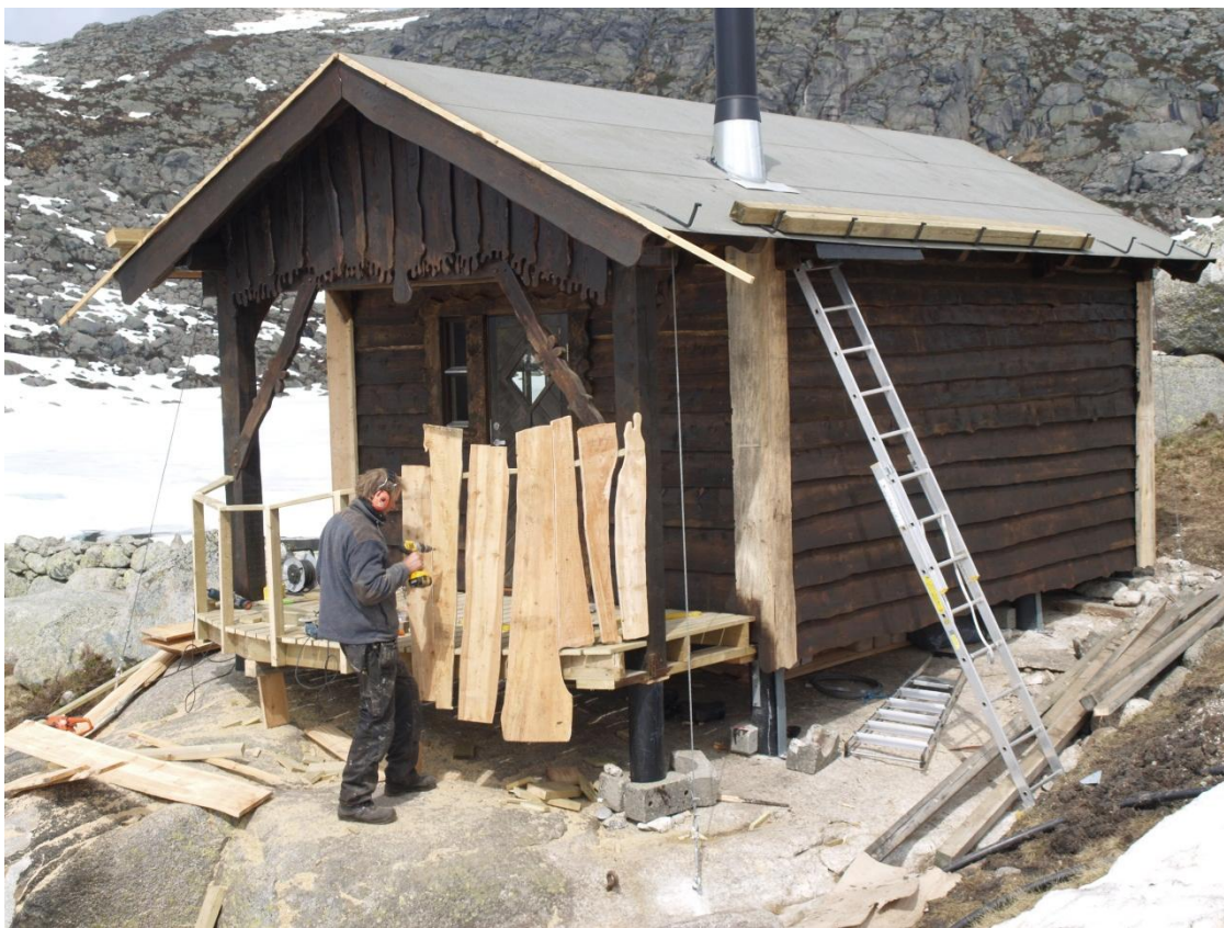
Figur 7 Sikringsbu ved Svartavatn
