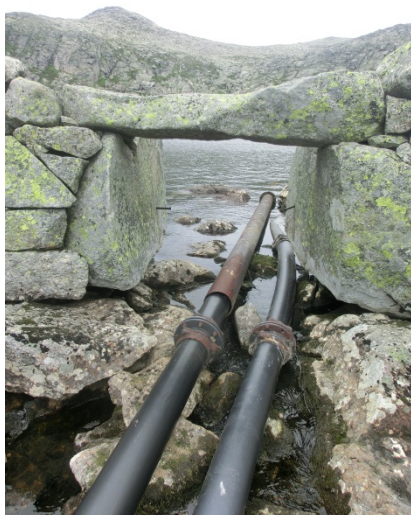
Figur 31. Foto av stemma ved Svartavatnet. Nederst til venstre er en åpning der det kan ha stått en port som kunne lukkes og åpnes. Alle foto: Asplan Viak as.
