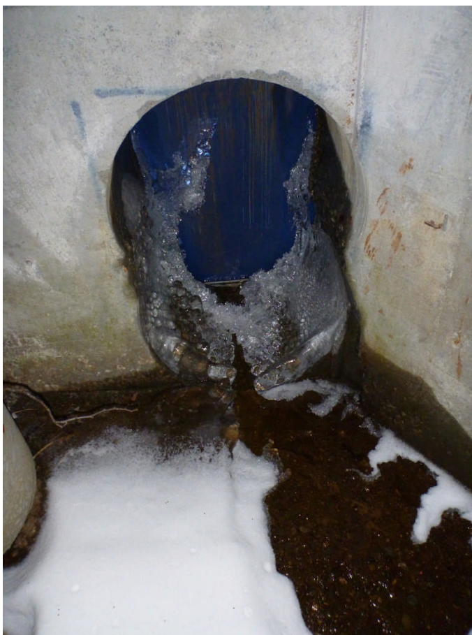
Figur 8. Nedvandringsslusen er en enkel innretning som leder den nedvandrende smolten videre til fisketrappa i stedet for inntaket.
