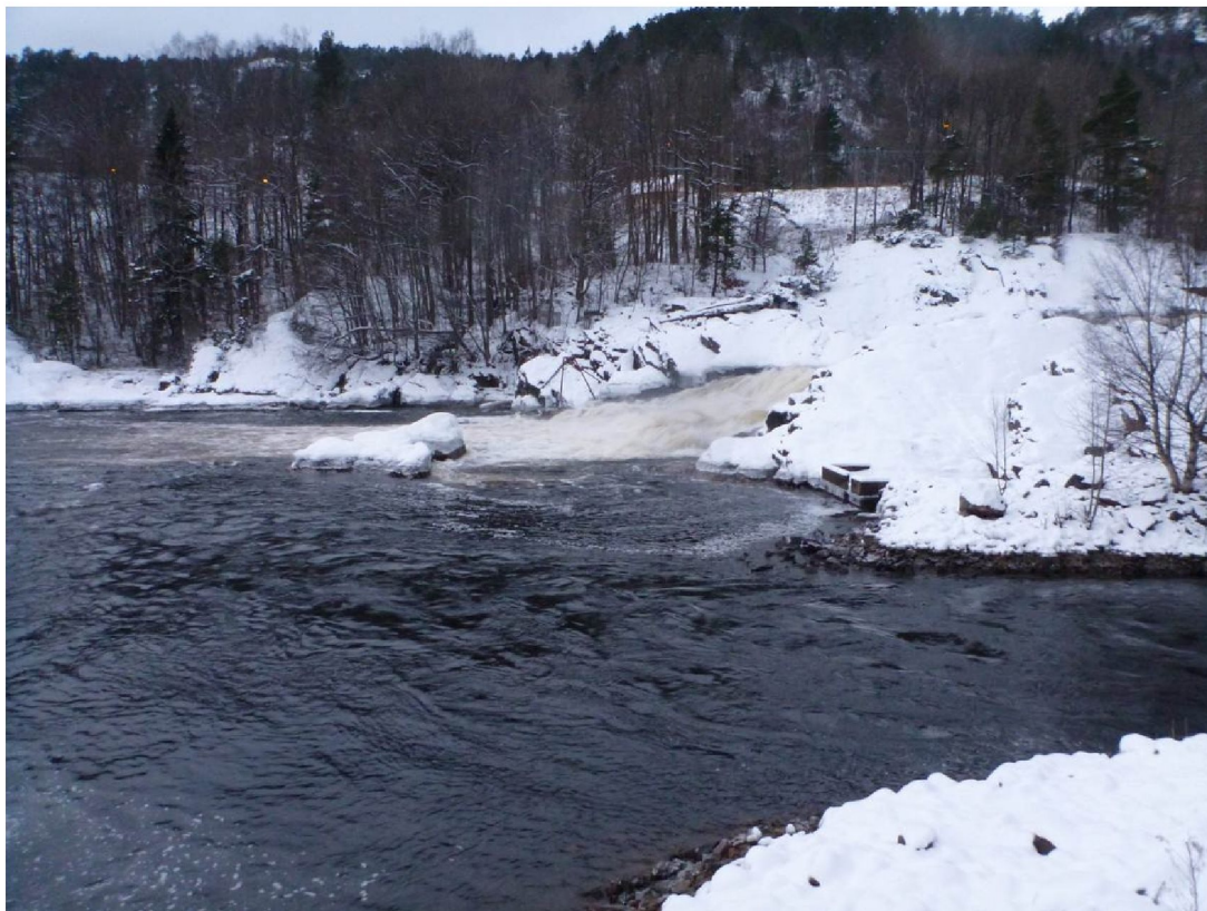
Figur 8. Boenfossen sett fra østsiden. Avløp fra kraftstasjonen nederst til høyre og fra fisketrappa ved siden av; foten av fossen ca. midt på bildet
