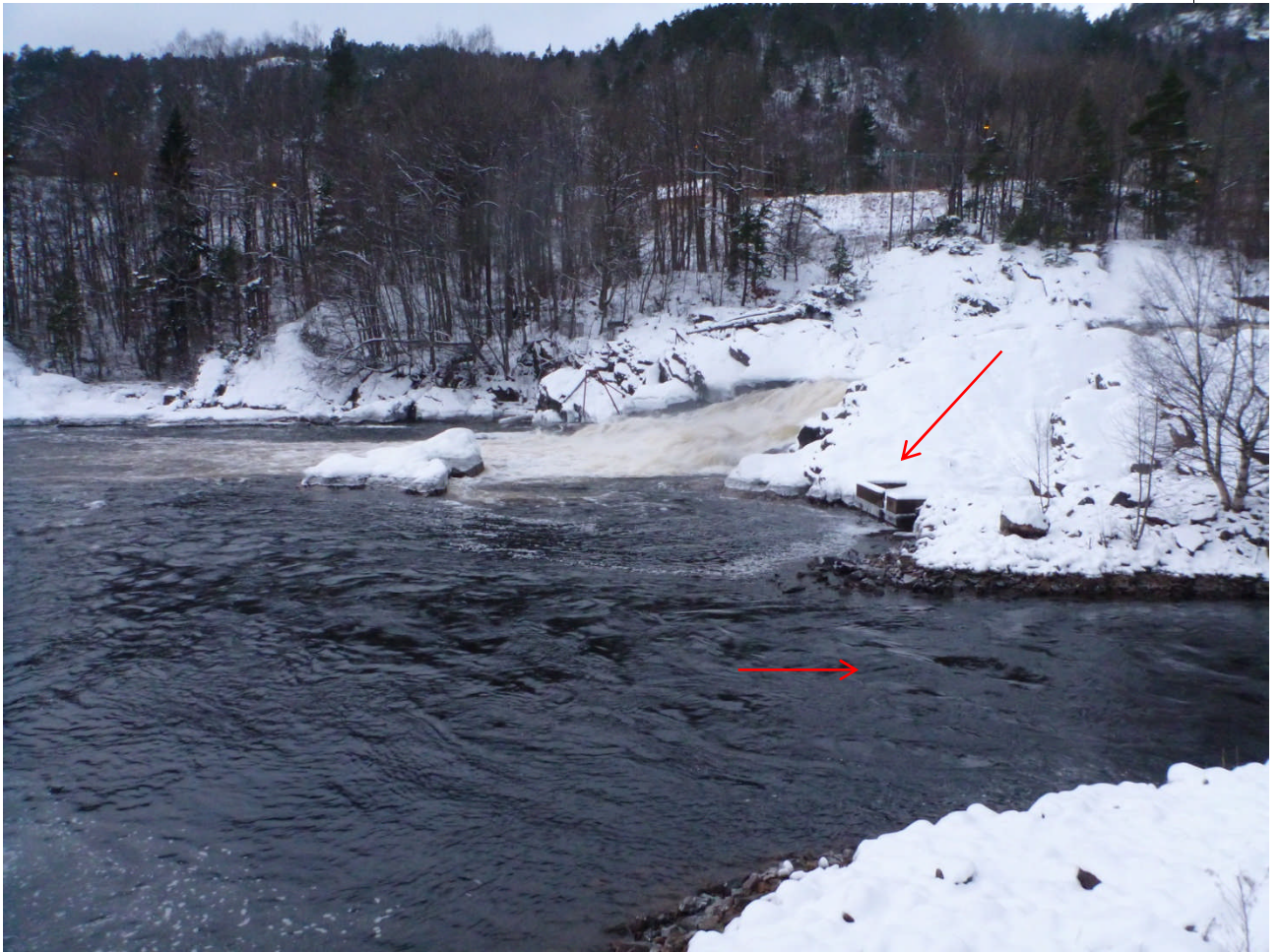
Figur 5. Boenfossen sett fra østsiden. Piler mot avløpskanal fra kraftverket og fisketrapp.
