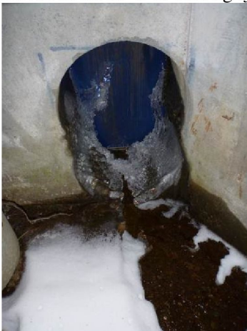
Figur 10. Nedvandringsslusa er en enkel innretning som leder den nedvandrende smolten videre til fisketrappa i stedet for til inntaket.
