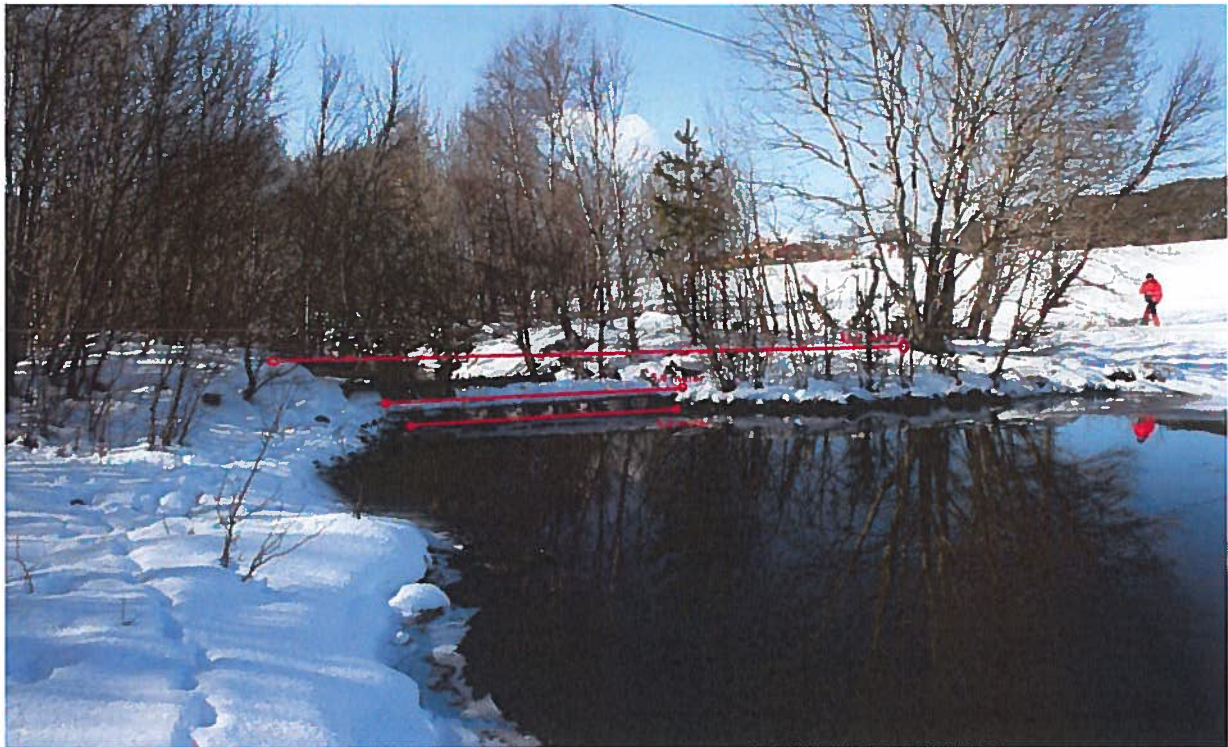
Figur 2 viser Dam Heimsvatnet sett fra oppstrøms side
