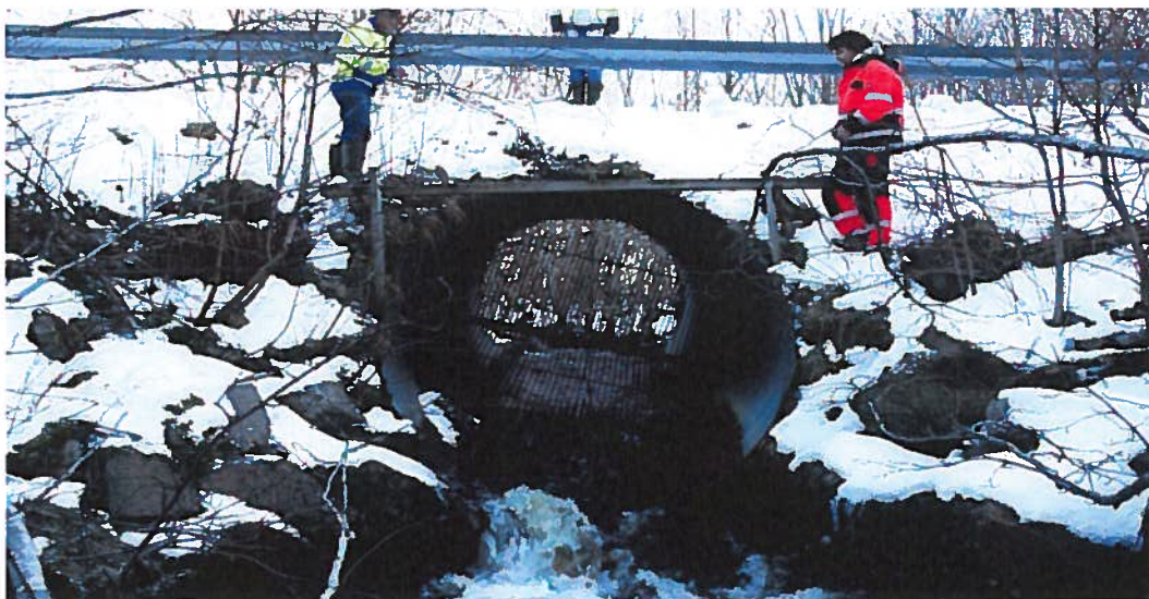
Figur 4 viser kulvert 1 hvor Belsvikbekken krysser
