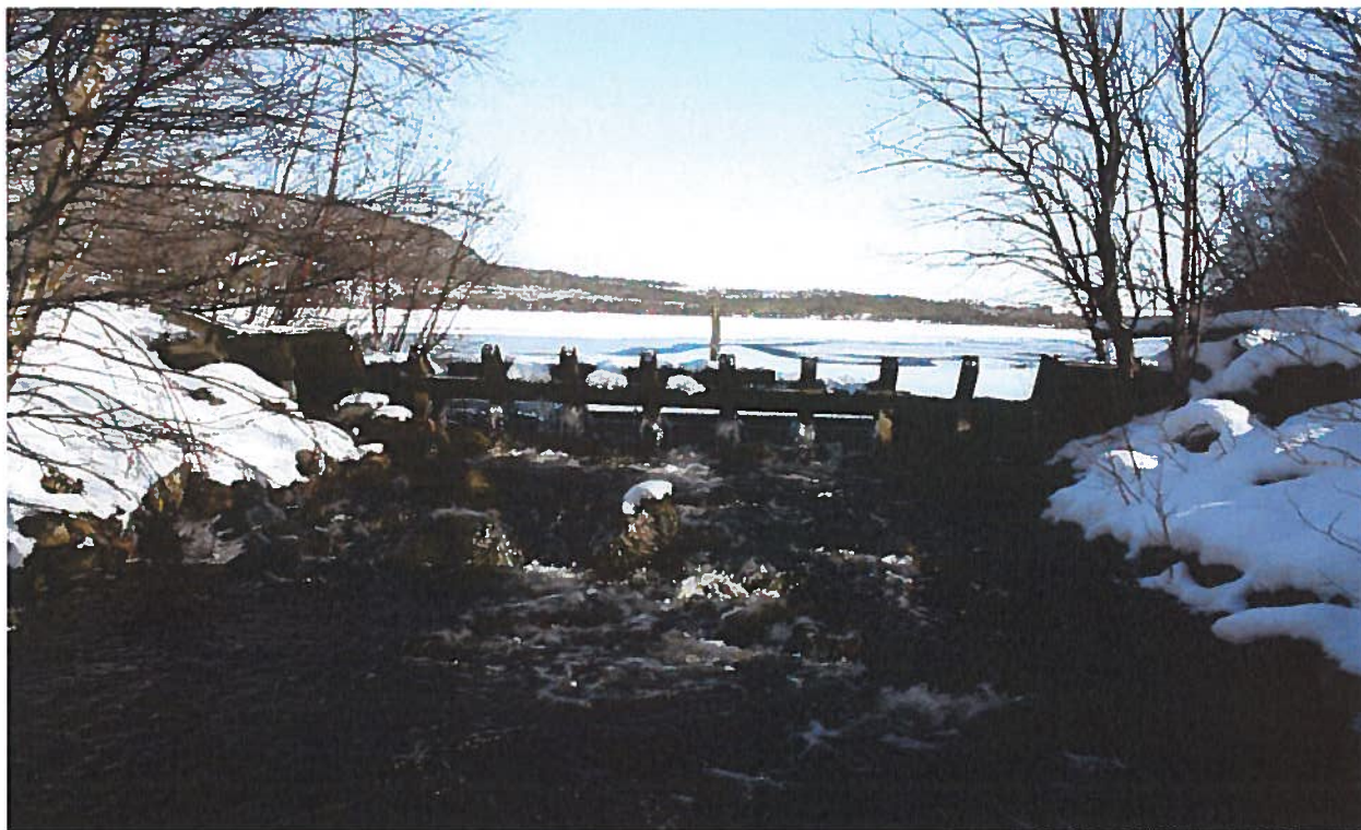
Figur 1 viser Dam Heimsvatnet sett fra nedstrøms side.
