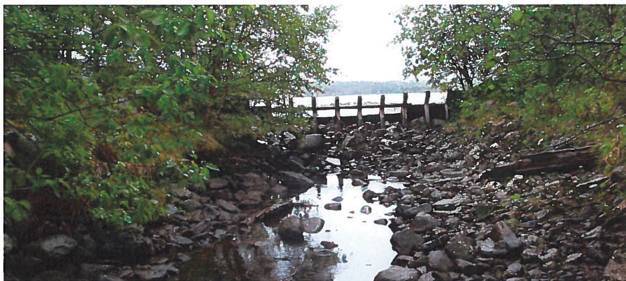
Figur 3. Demning sett fra Belsvikbekken. Mai 2009
