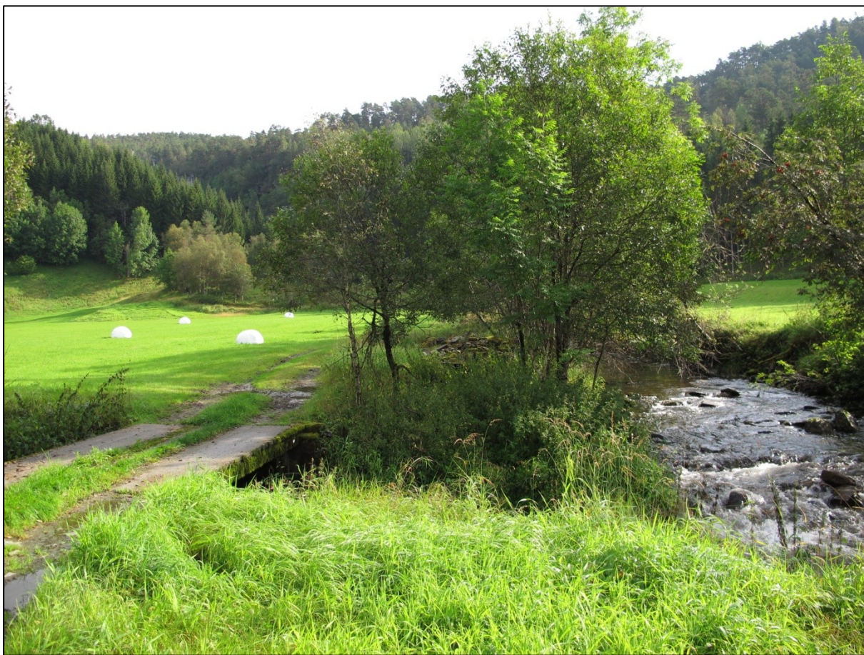
FIGUR 8: BILDET VISER PLASSERING KRAFTSTASJONEN SOM BLIR LIGGENDE PÅ ANDRE SIDE AV BROEN.
