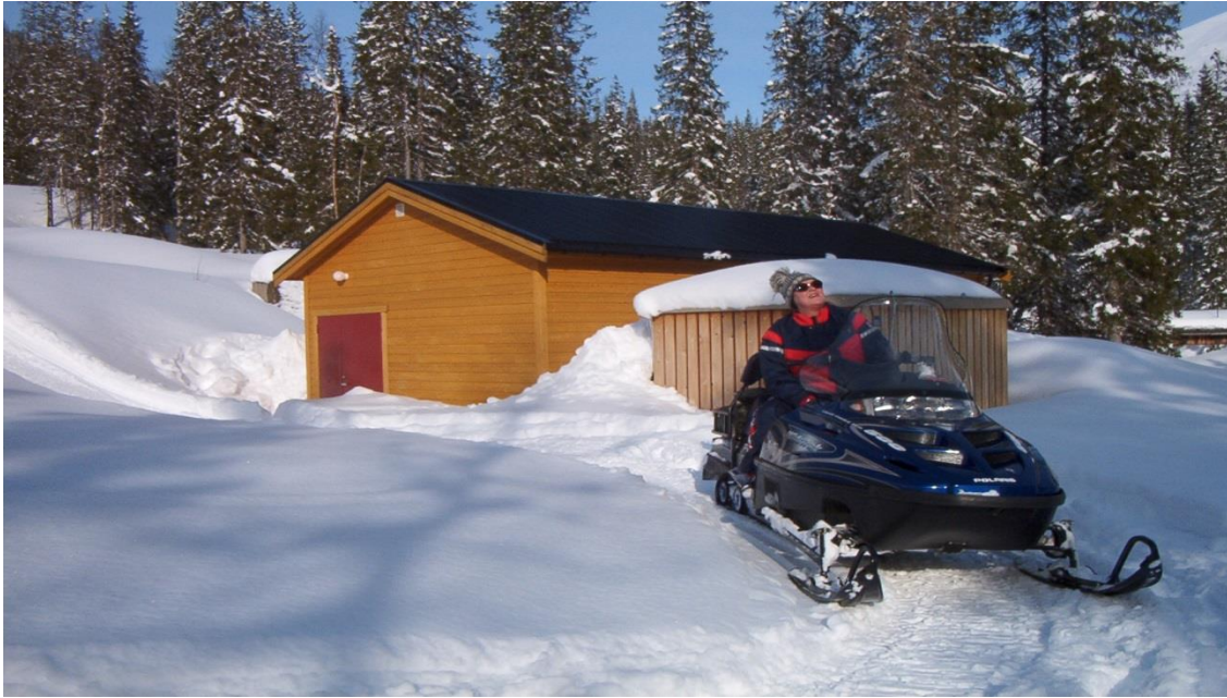
Foto viser Storrøvatnet kraftstasjon.
