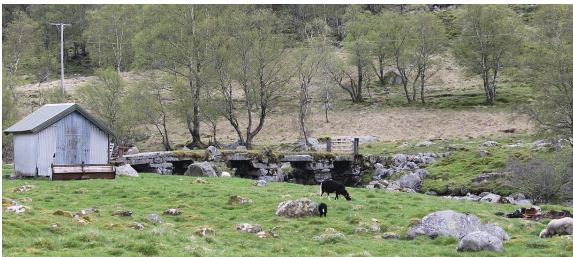
Figur 9-3 Gammel steinbro som krysser Madlandselva ved Vølstad. Foto: Atle Jenssen, Norconsult.
